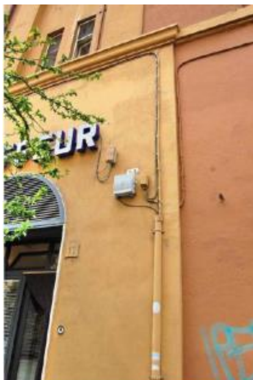
Esempi di installazione del PTA
