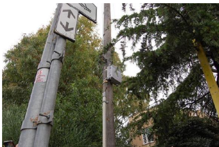
Esempi di installazione DEL PTA su palo
