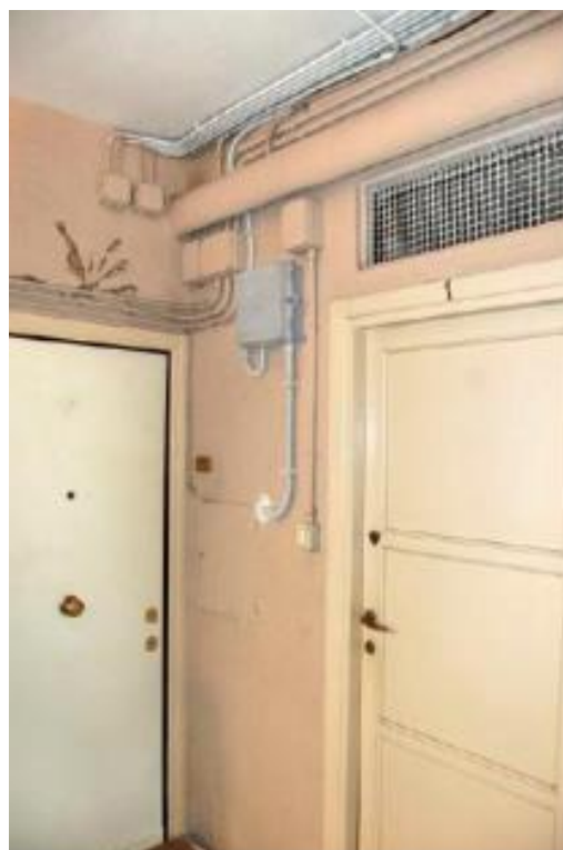
Esempi di installazione del PTA
