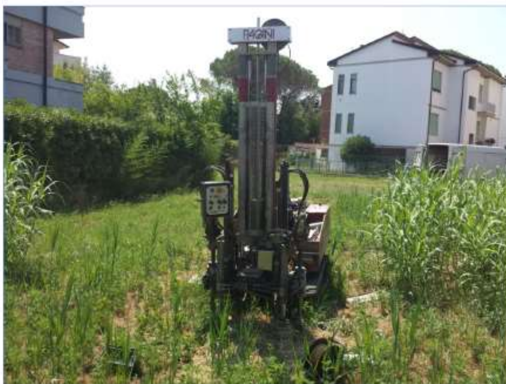
Figura 2: Prova penetrometrica CPT 2
