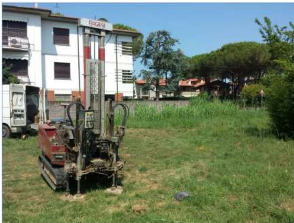
Figura 1: Prova penetrometrica CPT 1
