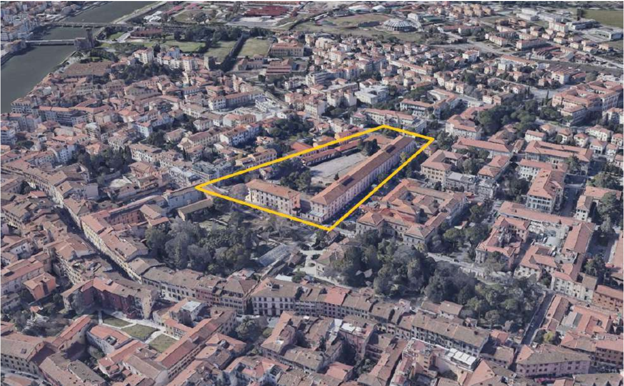
Figura 6.: Foto aerea Ex Caserma Artale – vista da Nord-Est
