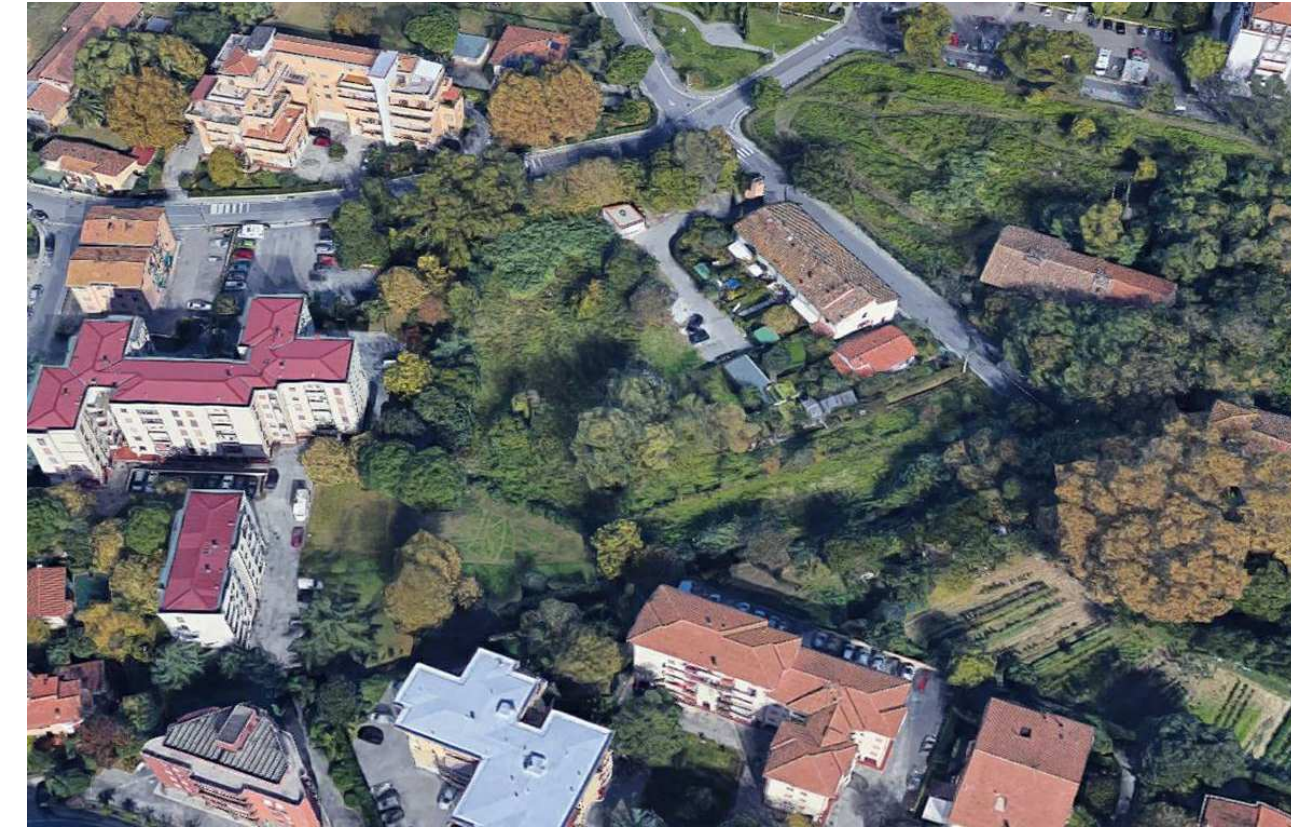
Vista Aerea da NORD
