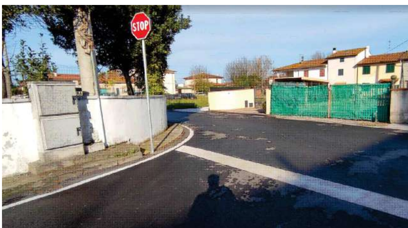
VISTA VISIBILITA' IN SINISTRA DA CORSA DI SINISTRA (VISIBILITA' INSUFFICIENTE PER V= 50 KM/H SECONDO IL DM. 19-4-2006)
