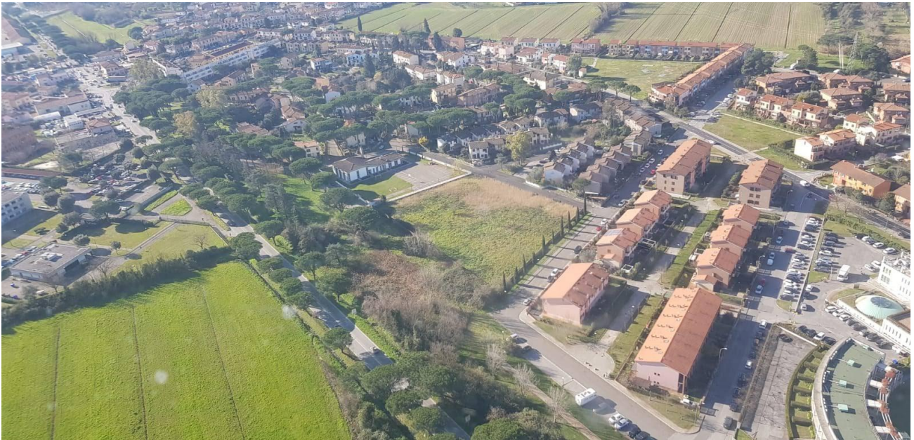
fig.6 STATO ATTUALE vista da nord est
