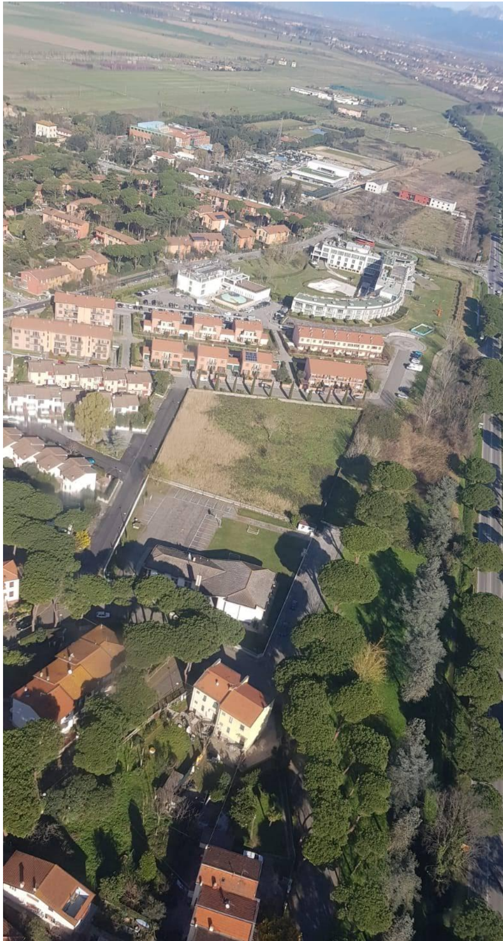
fig.8 STATO ATTUALE - vista da sud
