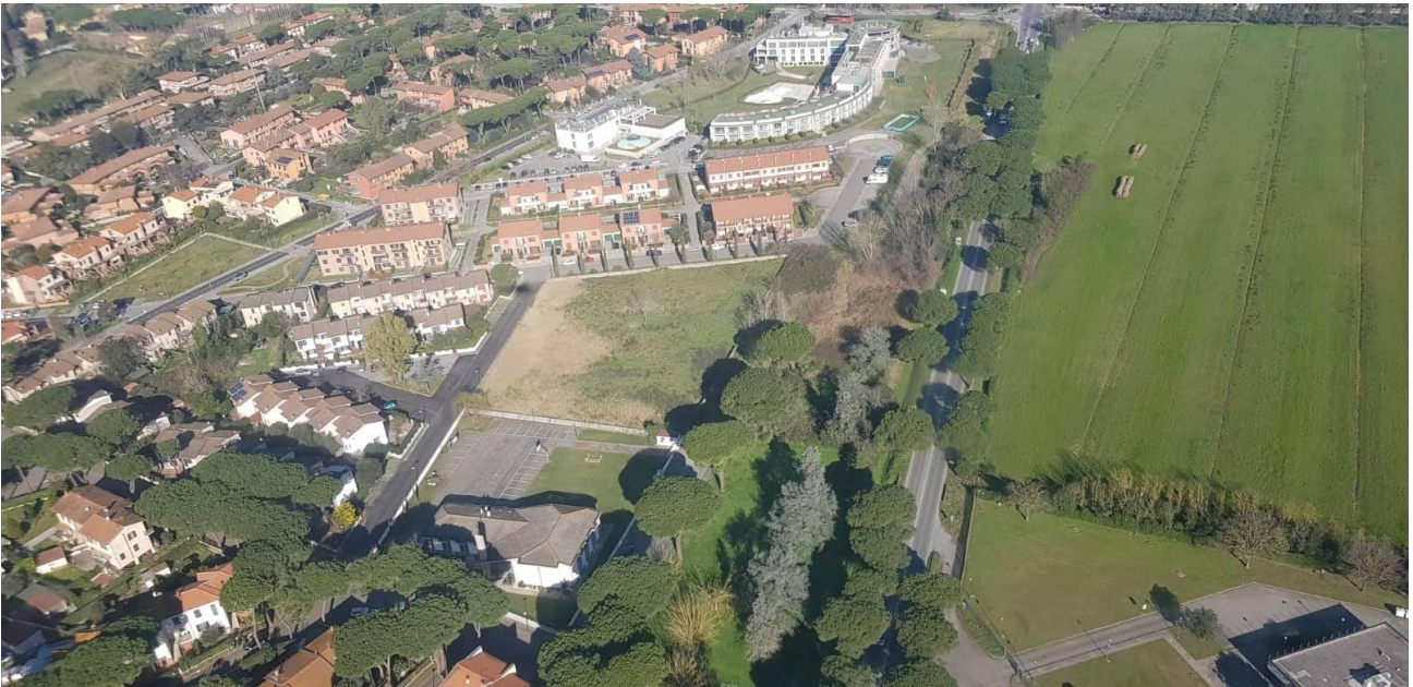
fig.7 STATO ATTUALE - vista da sud
