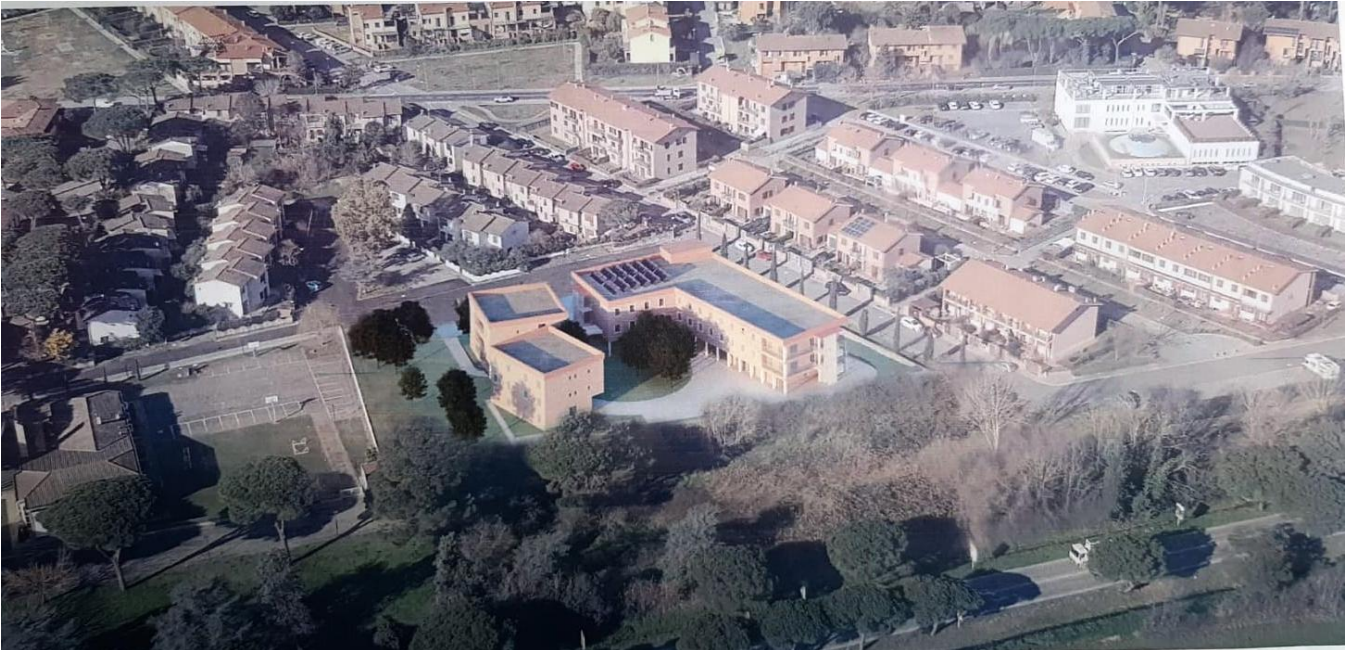
fig.5 STATO ATTUALE vista da sudest
