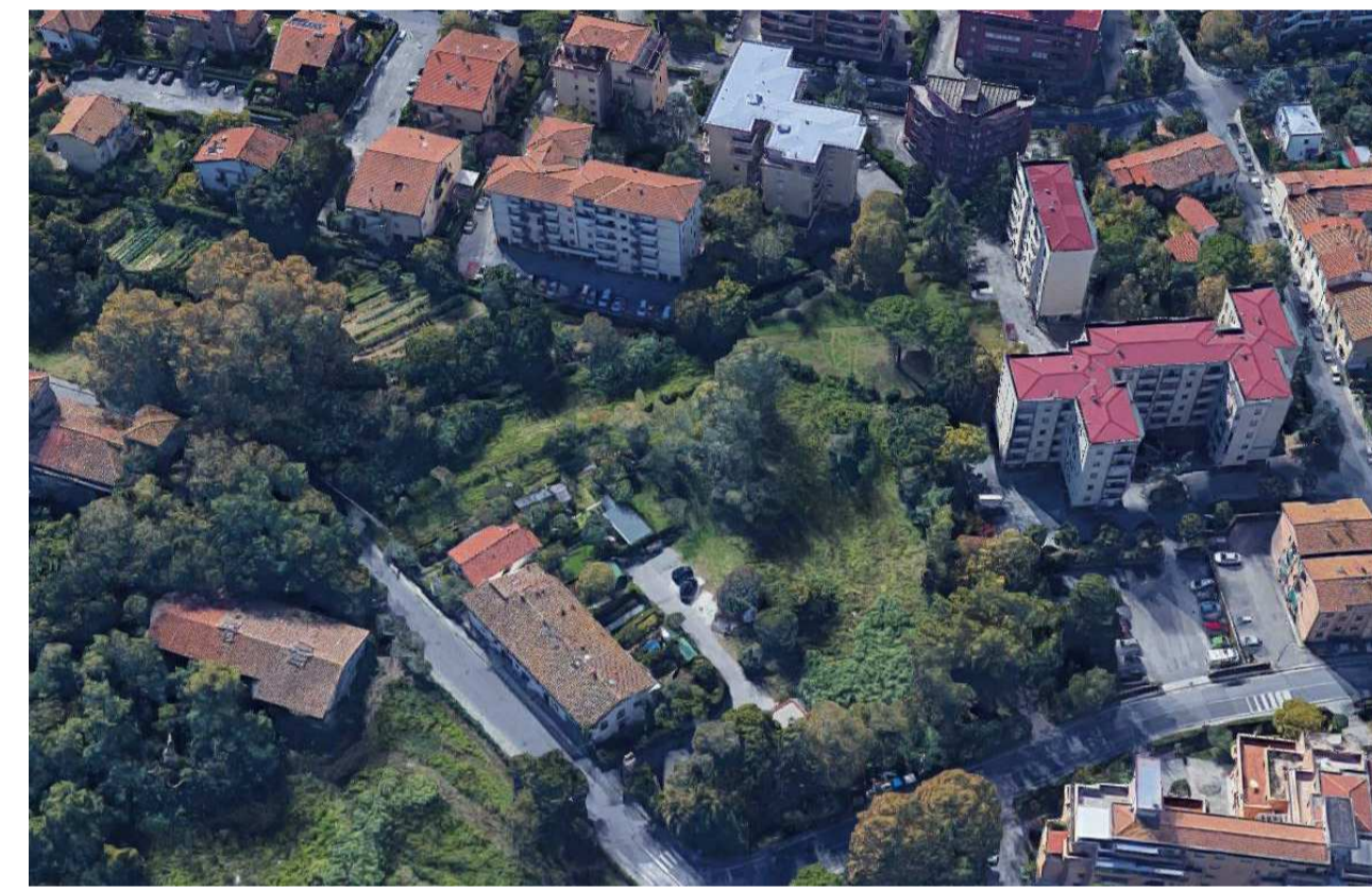
Vista Aerea da SUD
