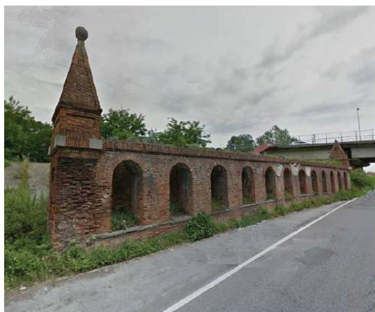
Le “Bocchette di Putignano” come appaiono oggi, poste al piede esterno dell’argine sinistro, nei pressi di Riglione.
