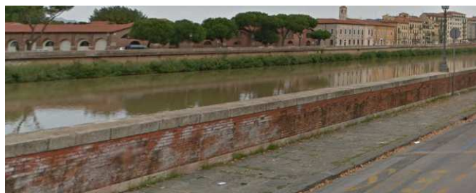
Gli argini costituiti dalle "spallette" che delimitano i lungarni
