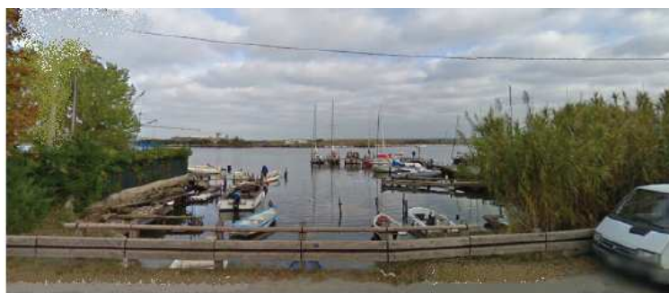
Confluenza in Arno dell'immissario dell'idrovora sul Canale Lamone
