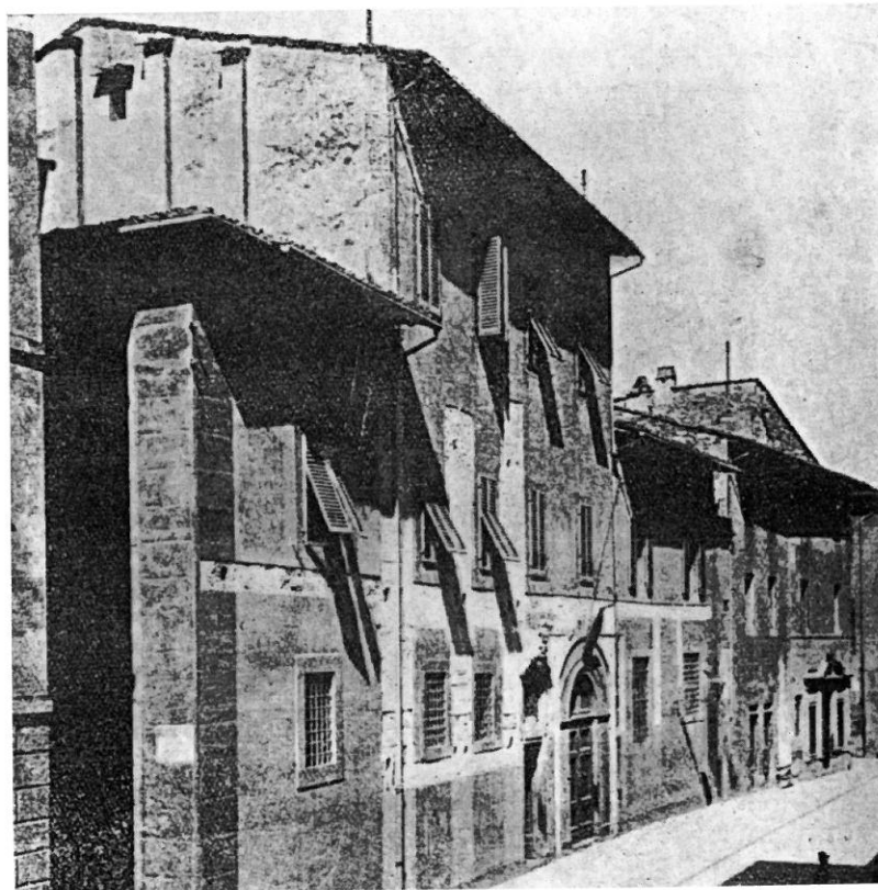
Facciata della Sapienza prima del rifacimento del primo 900
