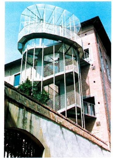
Scala di sicurezza del Palazzo Lanfranchi
