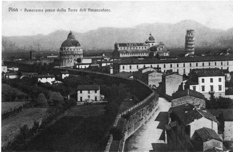
Il lato occidentale delle mura prima della demolizione
