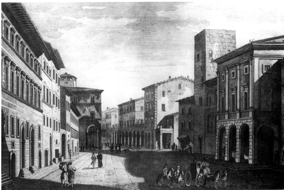
In questa veduta del Fambini (1790 c.a.) di Borgo Largo si notano preesistenze medievali assai più consistenti di adesso, a causa del successivo inglobamento in edifici ottocenteschi
