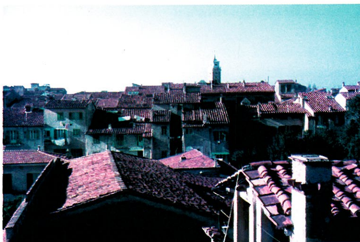
Omogeneità del tessuto edilizio di via Fucini.
