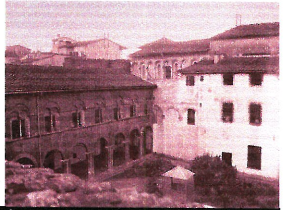
3 Chiostro lati sud est
