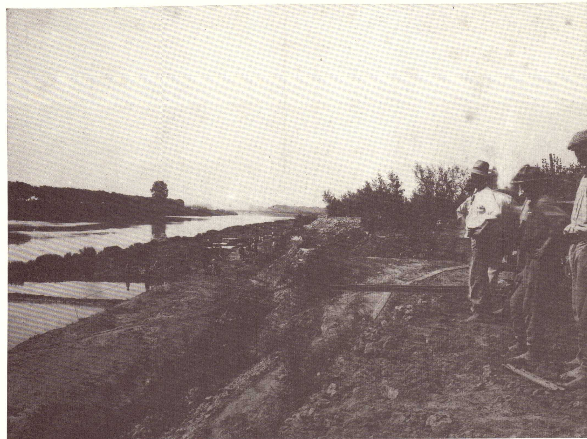
Lavori di ampliamento sezione Arno presso Barbaricina Ritaglio fino al piano delle magre ordinarie - Luglio Settembre 1920
