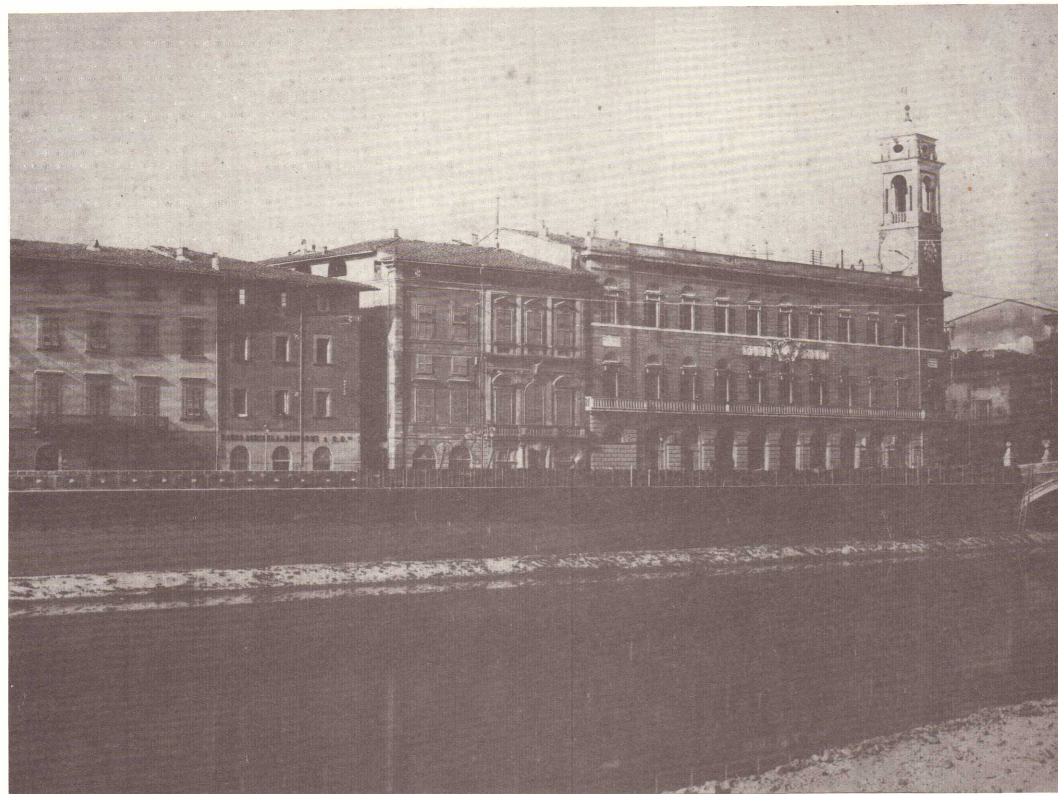
Ringrosso spallette murate traverso Pisa Riproduzione della via alzaia con lastre in cemento armato - Agosto - Settembre 1920
