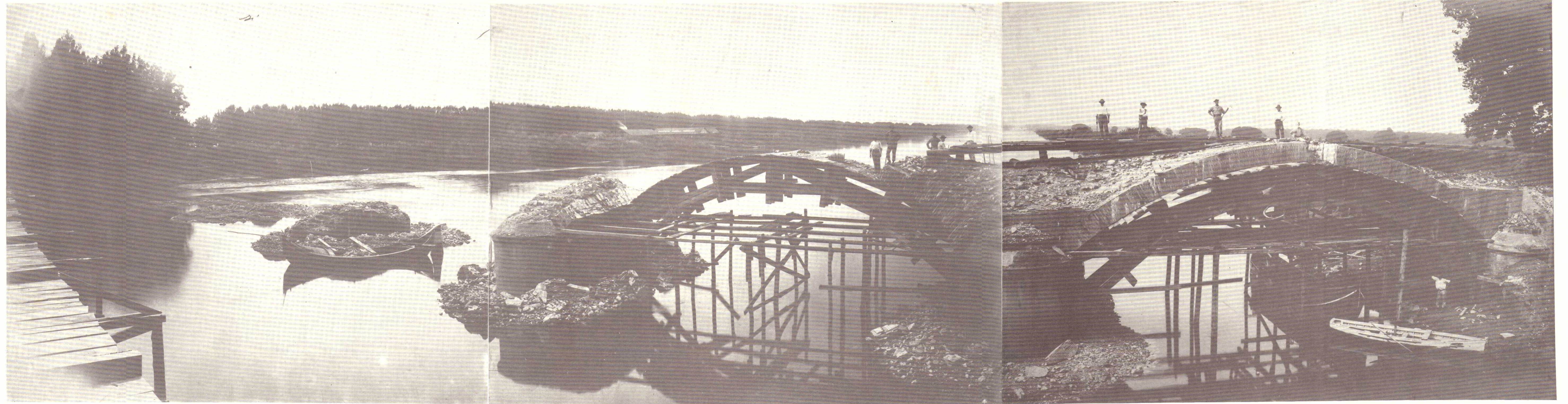
Ponte Vittorio Emanuele II presso S. Rossore sull'Arno Demolizione parte aerea - Aprile - Settembre 1920
