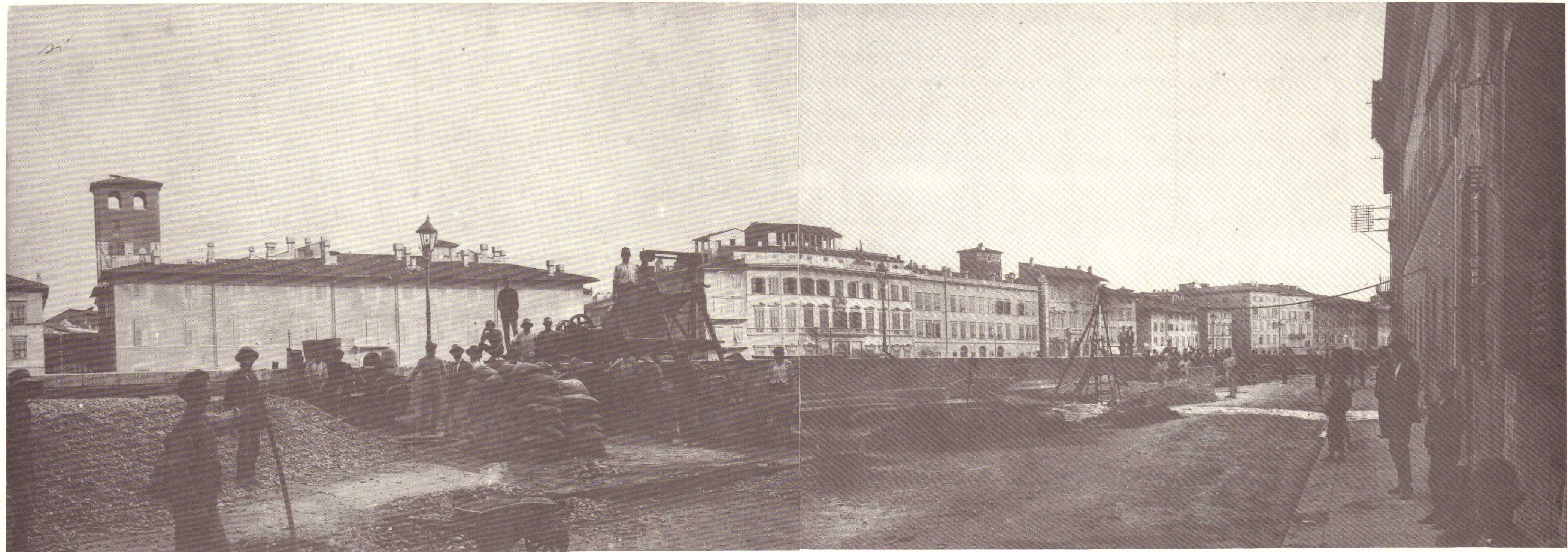
Ringrosso spallette murate traverso Pisa Agosto - Settembre 1920
