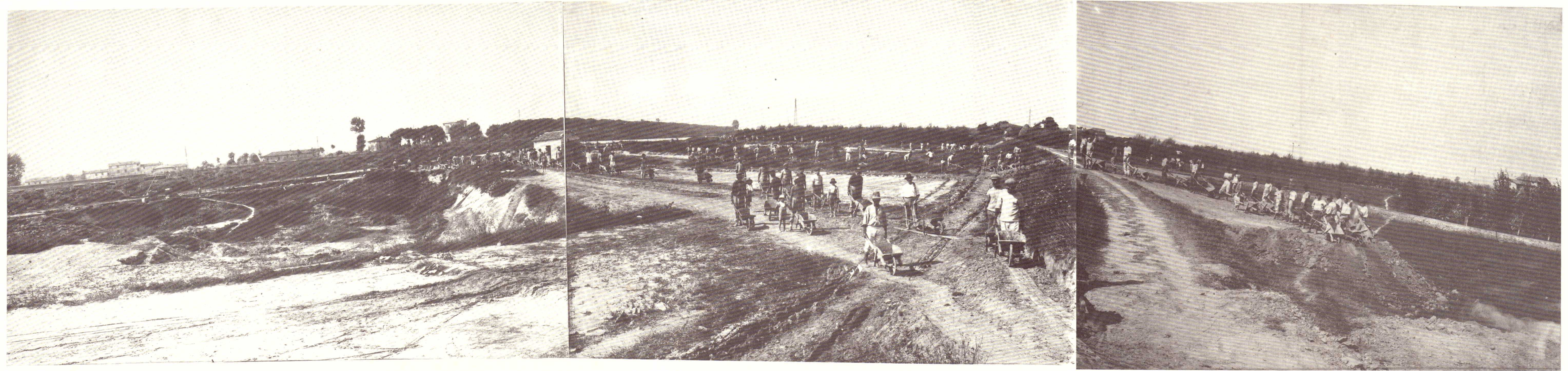
Lavori di ampliamento sezione Arno presso Barbaricina Luglio Dicembre 1920
