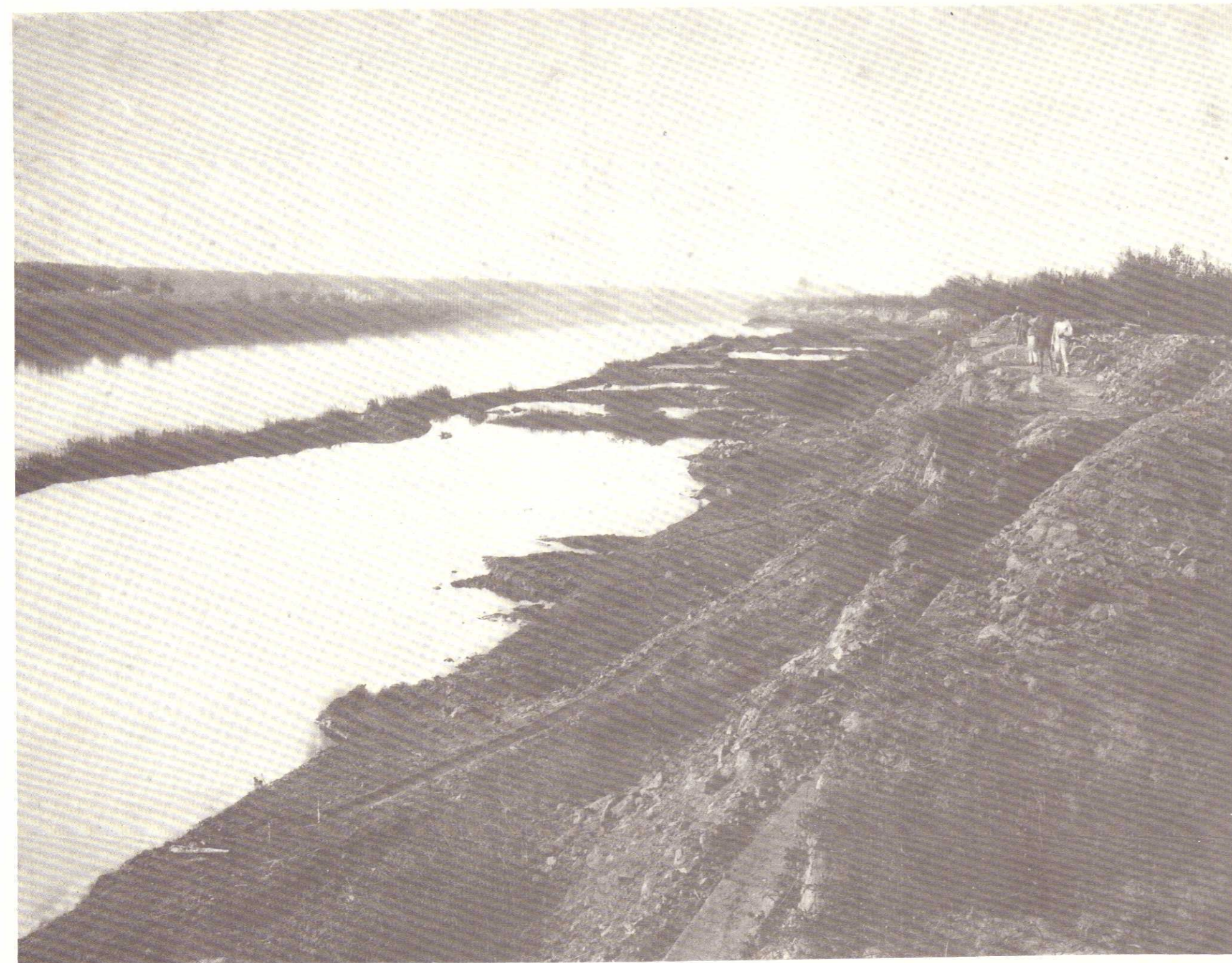
Lavori di ampliamento sezione Arno presso Barbaricina Abbassamento sotto il pelo delle magre ordinarie della banchina - Luglio Settembre 1920
