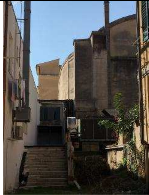
2- La scala di uscita di sicurezza
