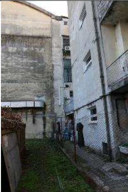
5 - L'area libera retrostante l'edificio di via Turati
