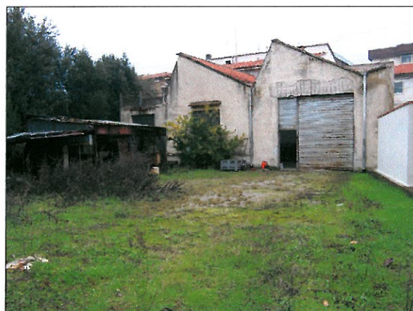
Foto 2 - Veduta del lato sudoccidentale dell'area in oggetto.
