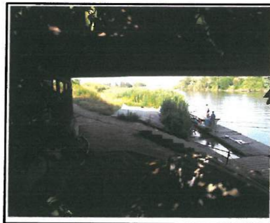
FOTO 3: Sottopassaggio del Ponte del CEP
