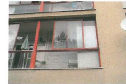
8 - Finestra serra Lato Sud
