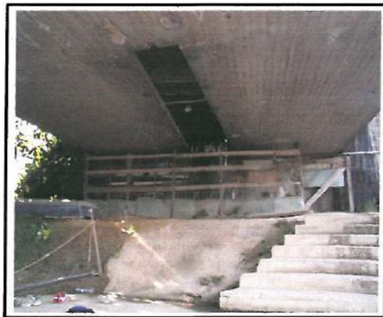
FOTO 3: Sottopassaggio del Ponte del CEP
