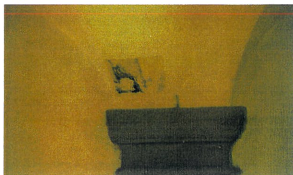
S1 Vano ingresso principale. Il saggio evidenzia decorazioni a fasce in corrispondenza delle lunette.
