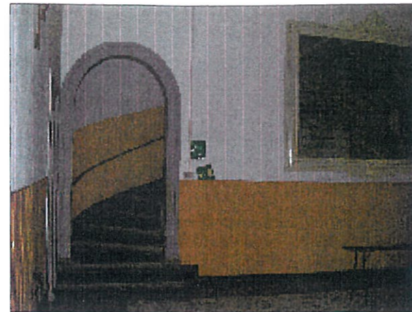
2) VANO ACCESSO ALLA SCALA PRINCIPALE
