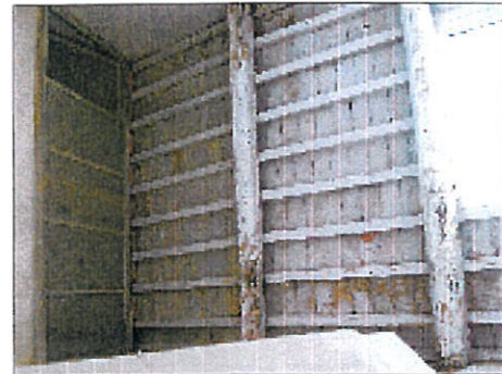
5) DEPOSITO CON COPERTURA IL LEGNO
