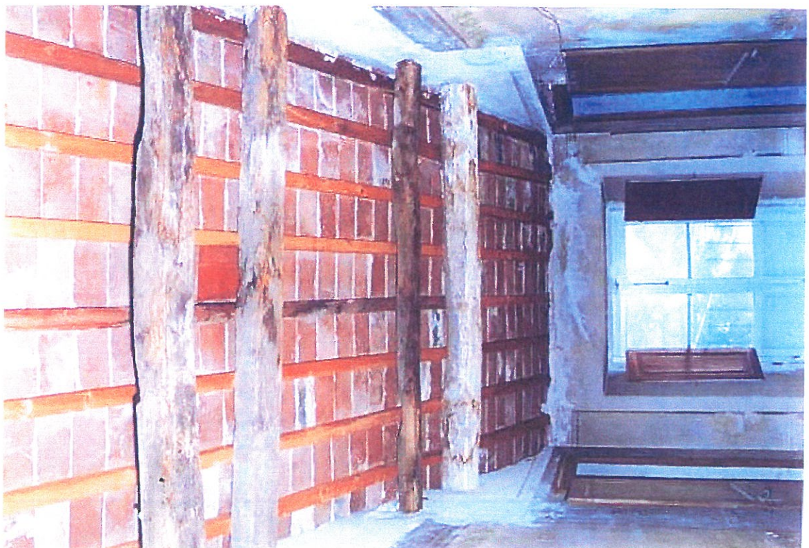
FIG . 54, EDIFICIO ANTICO, PIANO SECONDO, LATO NORD
