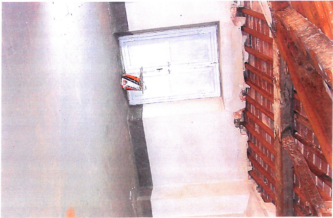
FIG 58 COPERTURA PIANO SECONDO
