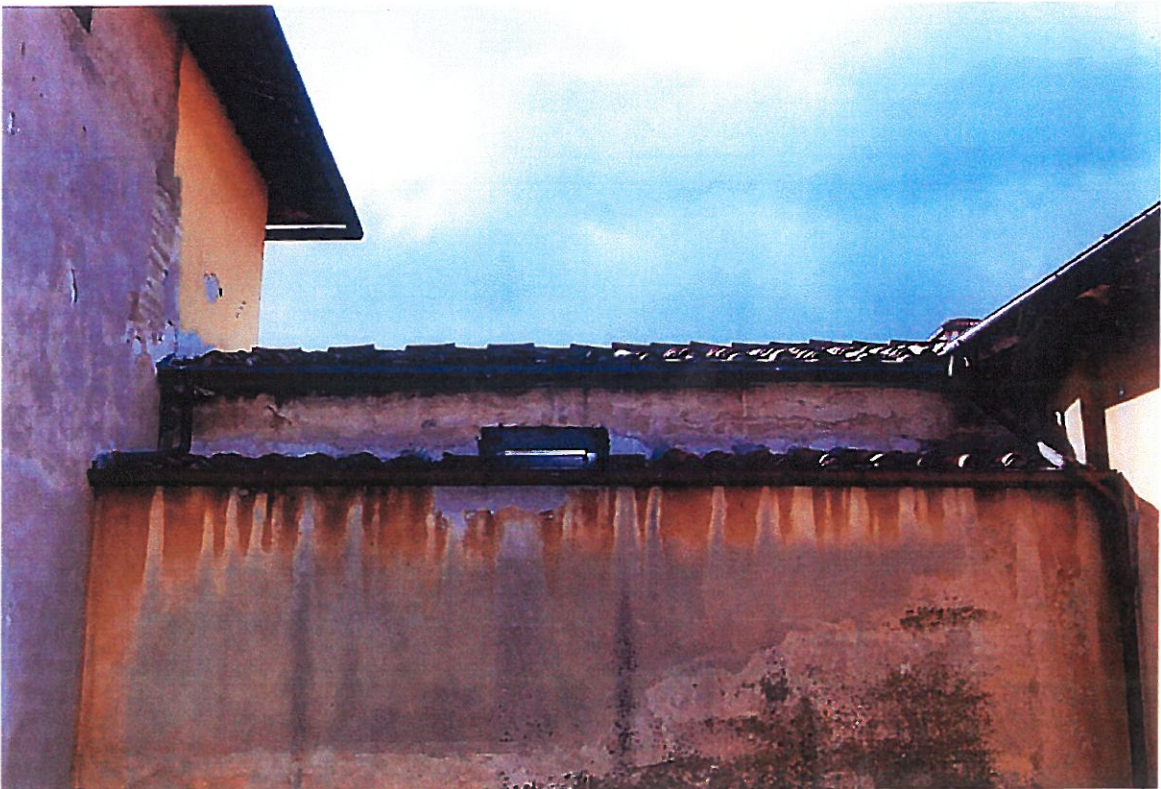
FIG . 9C. VISTA DALLA CORTEDEL VOLUME DA DEMOLIRE
