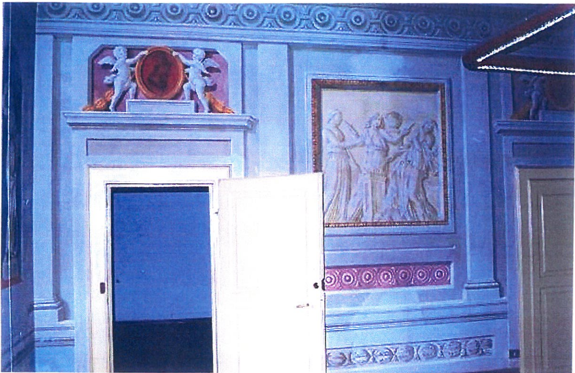
FIG . 47, EDIFICIO ANTICO, SALA AFFRESCATA LATO SUD
