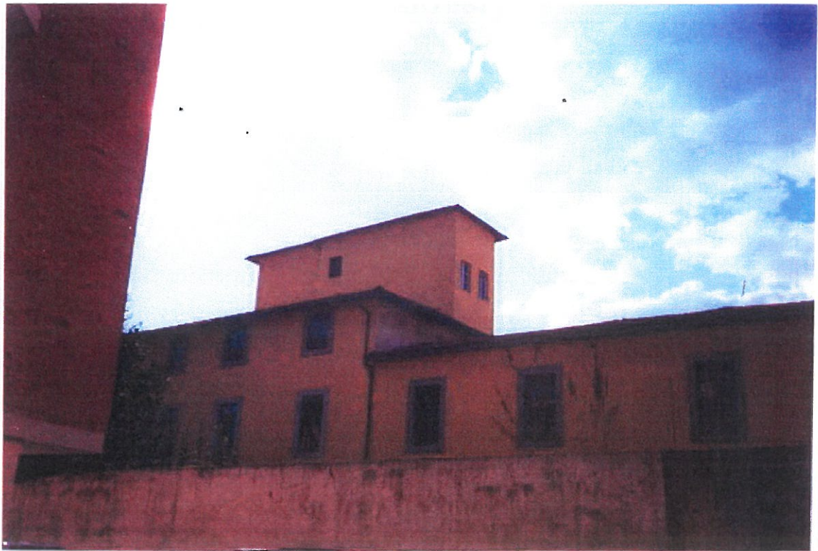
FIG.6, LATO NORD SUL LATO GIARDINO
