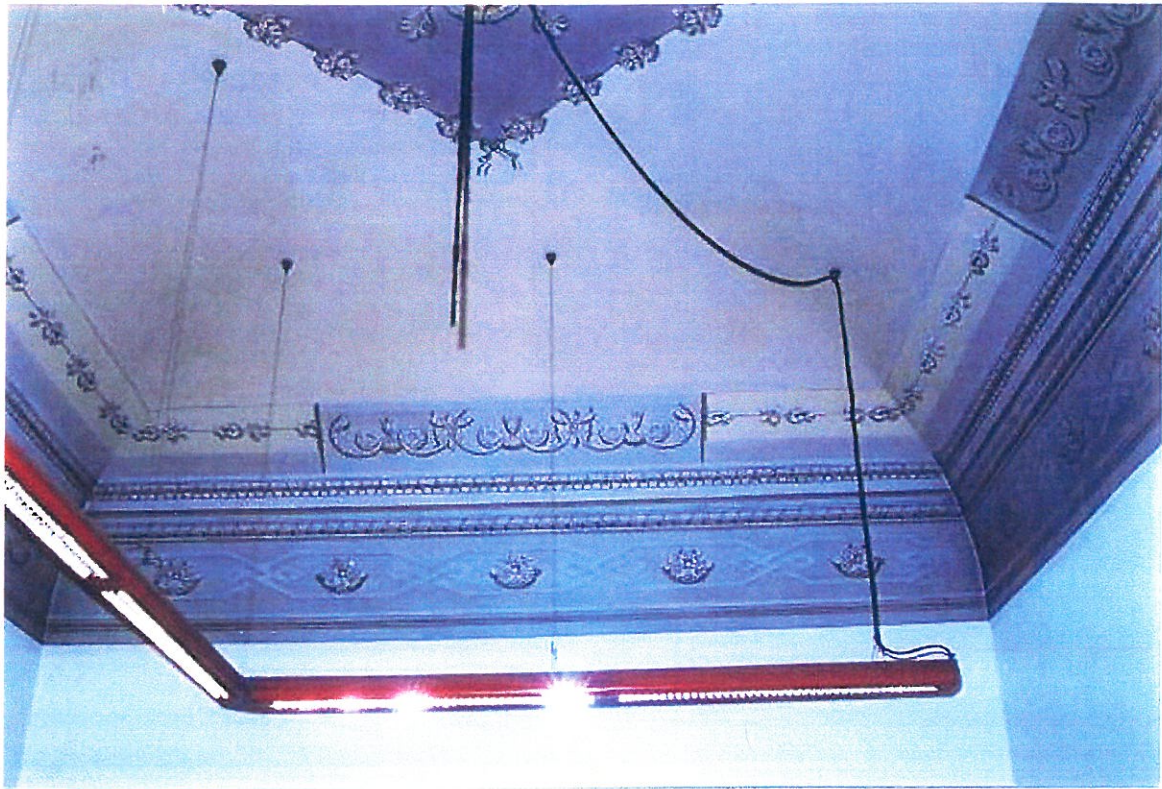
FIG . 49, EDIFICIO ANTICO, SALA AFFRESCATA, LATO SUD
