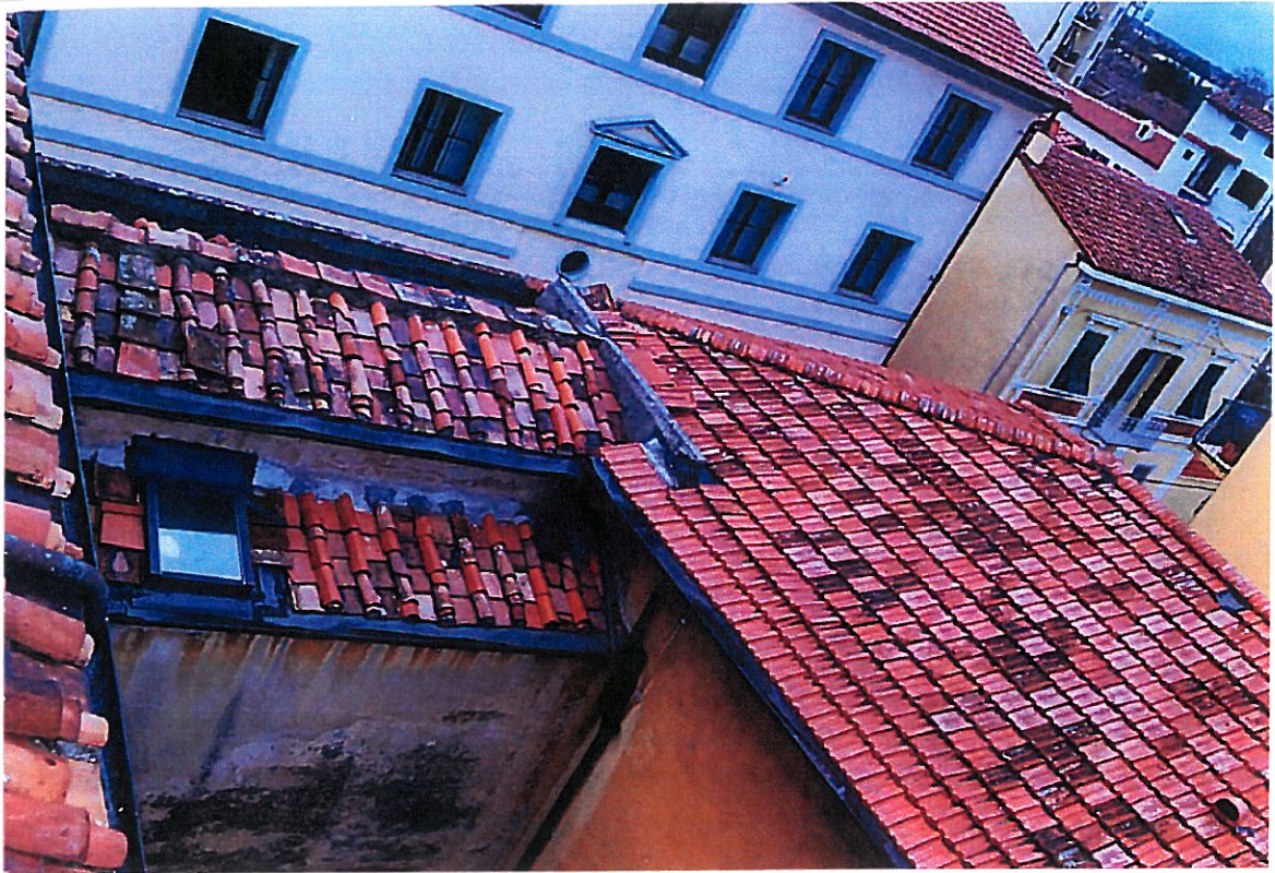
FIG . 9B VISTA DALL'ALTO DELLA COPERTURA DEL VOLUME DA DEMOLIRE
