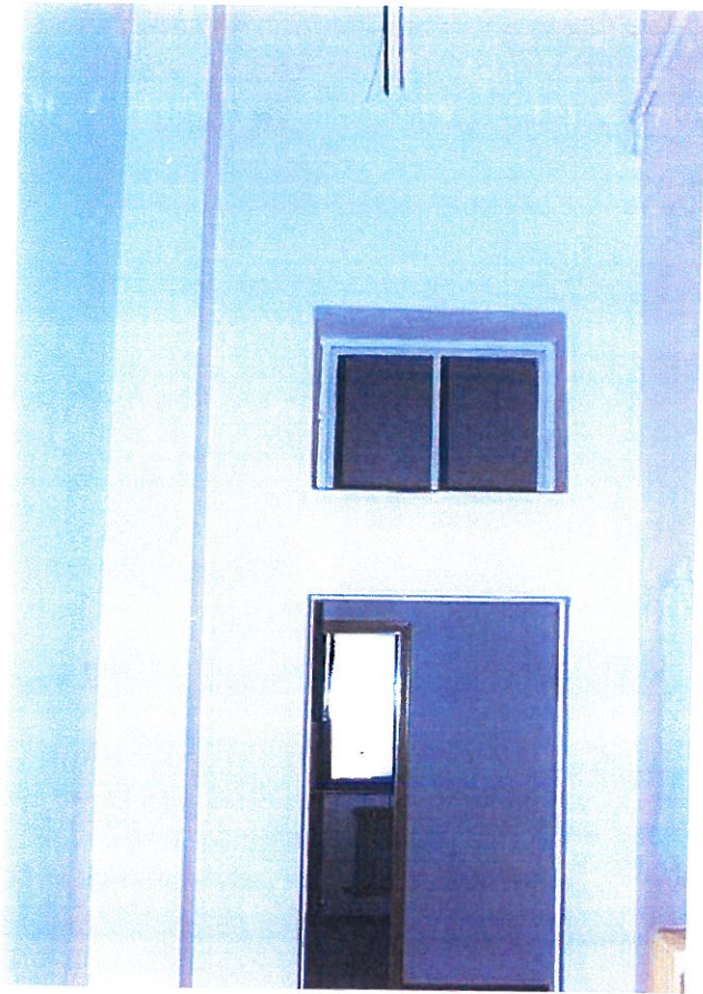
FIG . 43A, EDIFICIO ANTICO, PIANO PRIMO, DISIMPEGNO LATO EST
