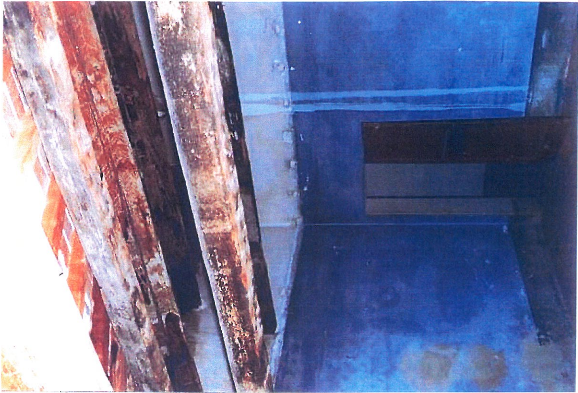
FIG . 55, EDIFICIO ANTICO, PIANO SECONDO, LATO SUD
