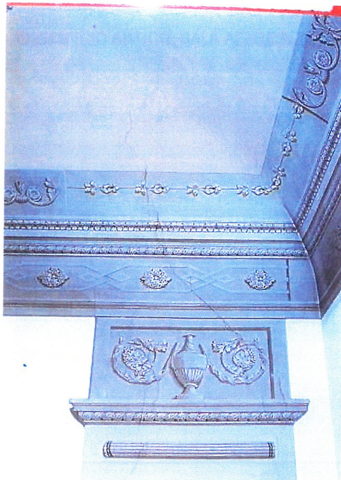
FIG . 48, EDIFICIO ANTICO, SALA AFFRESCATA, LATO SUD
