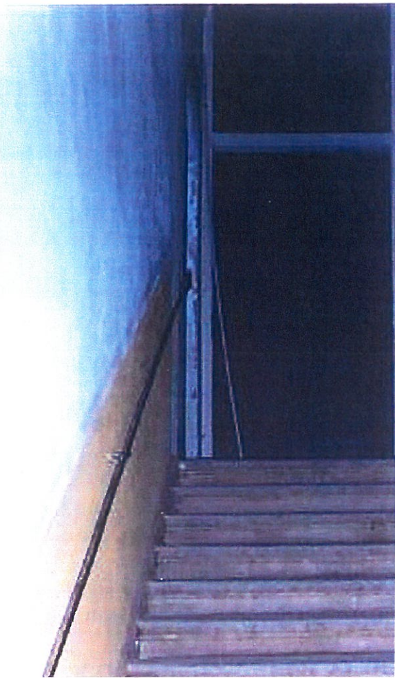
FIG . 51, EDIFICIO ANTICO, MEZZANINO FRA PRIMO PIANO E SECONDO
