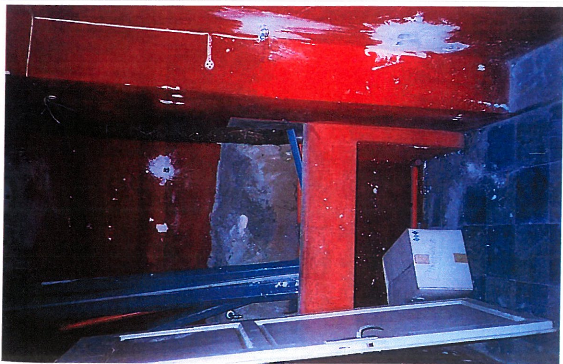
FIG . 36 C. PIANO PRIMO LOCALE ACCANTO ALLA TRIFORA
