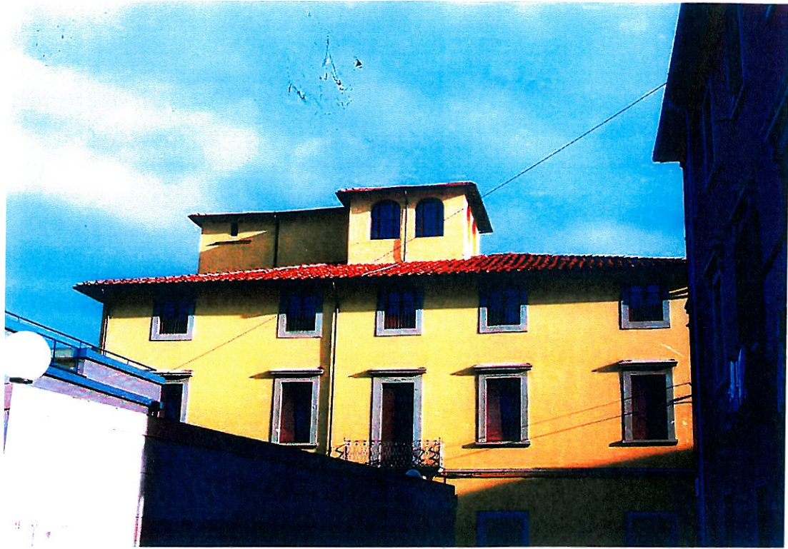
FIG.1, LATO SUD SU VIA VOLTURNO
