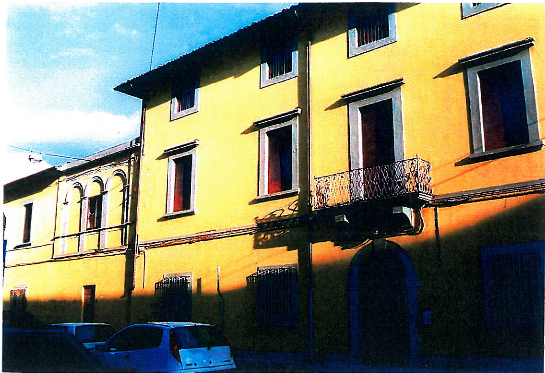
FIG.2A, LATO SUD SU VIA VOLTURNO
