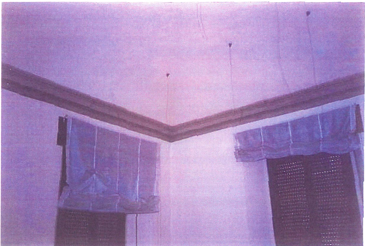
FIG . 42A, EDIFICIO ANTICO, PIANO PRIMO, LATO NORD EST
