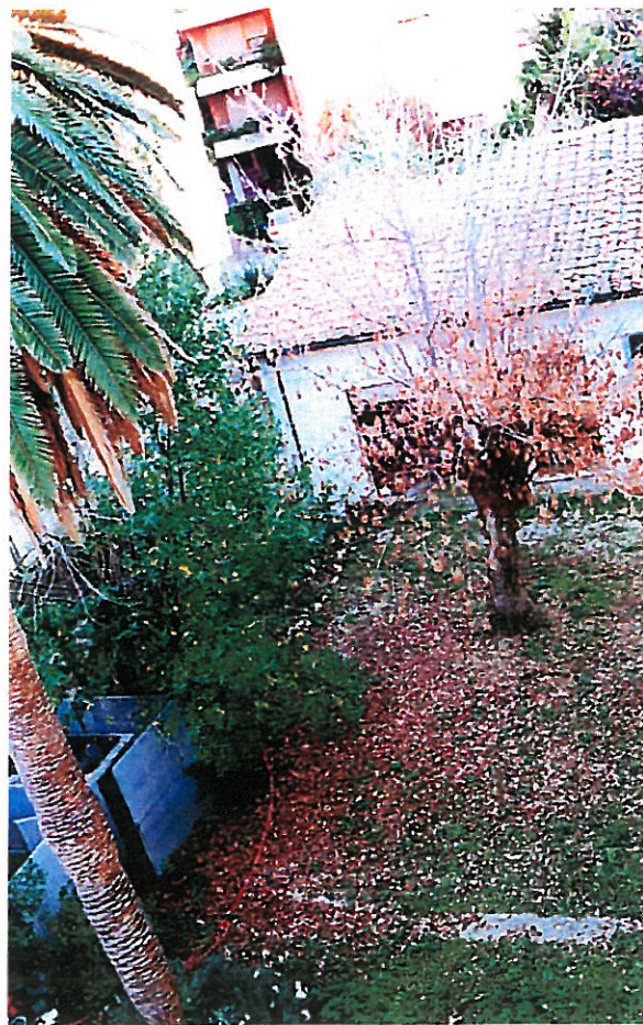
FIG . 8B. ANNESSI ESTERNI, VISTA DAL GIARDINO
