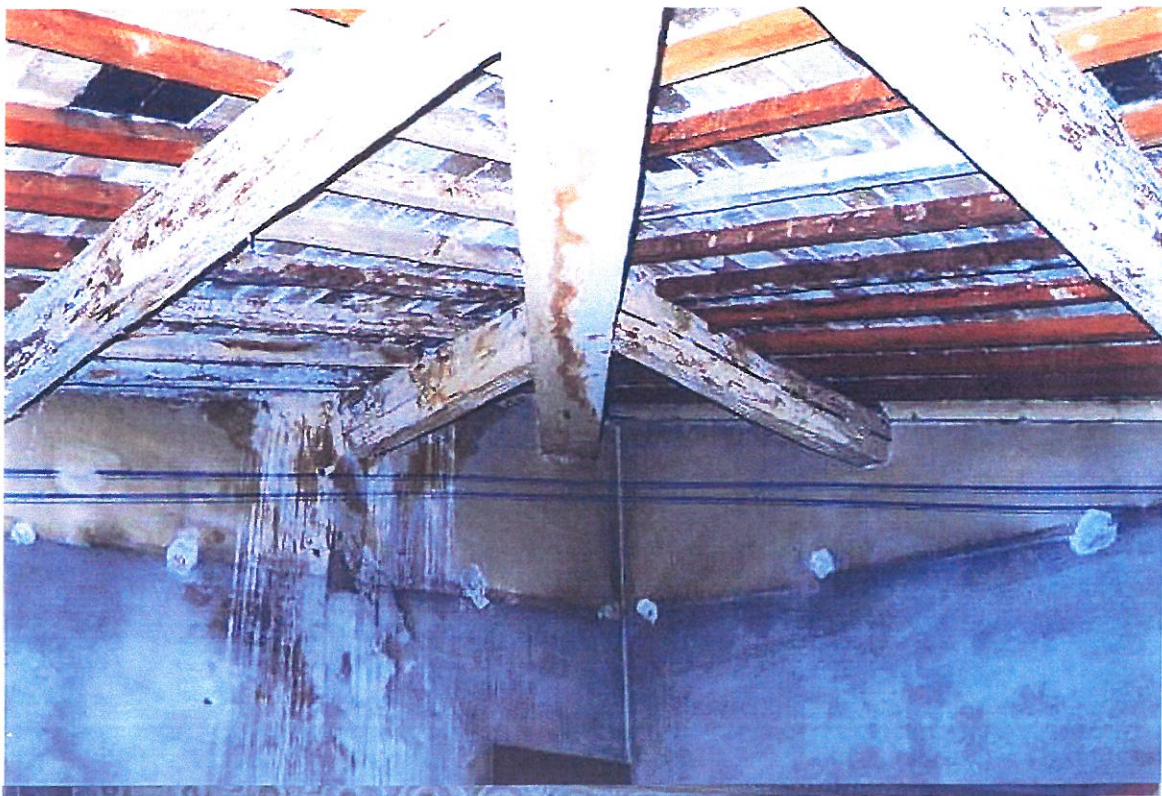
FIG . 56, , EDIFICIO ANTICO, PIANO SECONDO, LATO NORD
