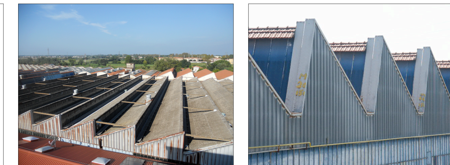
Particolari shed di copertura
