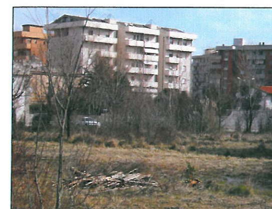
foto 7: N° 7 PIANI FUORI TERRA CIRCA 21 m DI ALTEZZA
