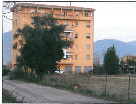
foto 1: N° 6 PIANI FUORI TERRA CIRCA 18 m DI ALTEZZA
