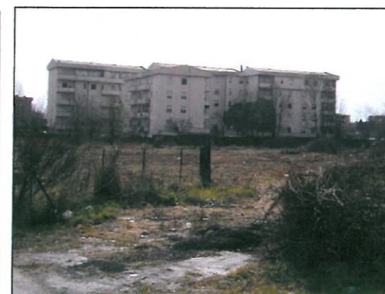
foto 9: N° 6 PIANI FUORI TERRA CIRCA 18 -M DI ALTEZZA
