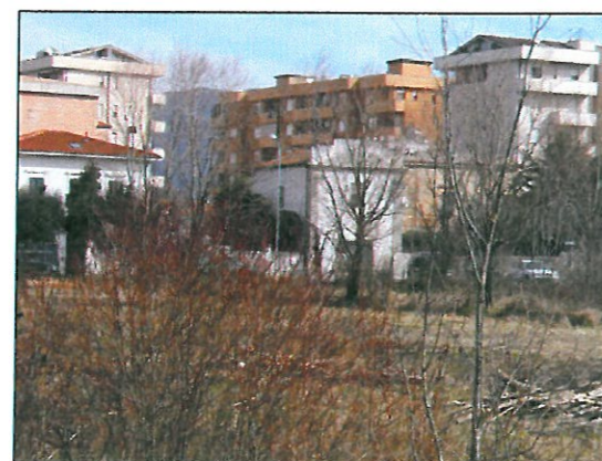
foto 6: N° 7 PIANI FUORI TERRA CIRCA 21 m DI ALTEZZA
