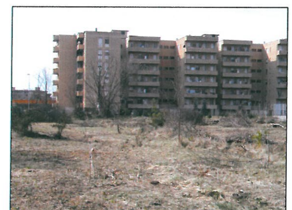
foto 10: N° 7 PIANI FUORI TERRA CIRCA 21 m DI ALTEZZA
