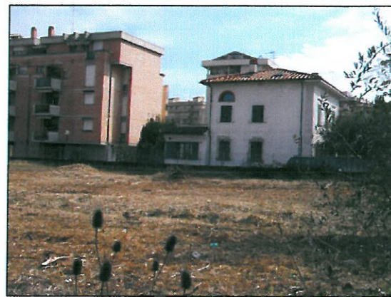
foto 5: N° 2 PIANI FUORI TERRA CIRCA 6 m DI ALTEZZA
