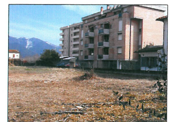
foto 4: N° 5 PIANI FUORI TERRA CIRCA 15 m DI ALTEZZA
