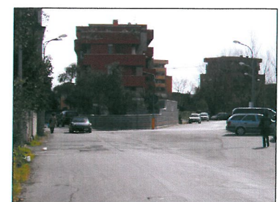
foto 8: N° 6 PIANI FUORI TERRA CIRCA 18 m DI ALTEZZA
