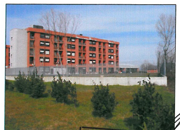
foto 12: N° 5 PIANI FUORI TERRA CIRCA 15 m DI ALTEZZA
