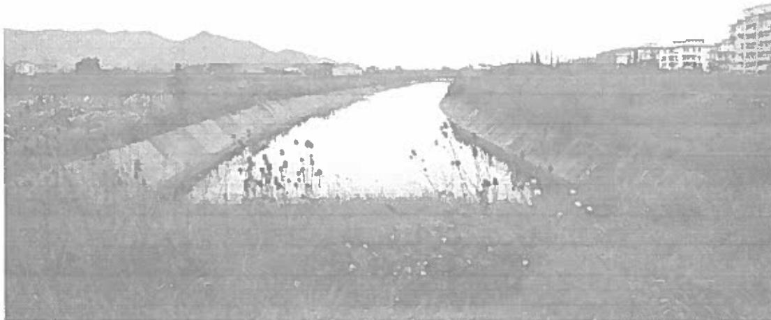
foto del nuovo canale in c.a. che porta alle idrovore.
