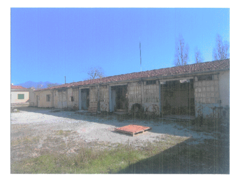
edificio C corte interna lato ovest
