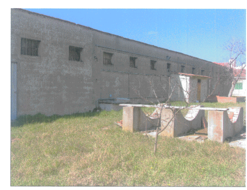
edificio C prospetto est
