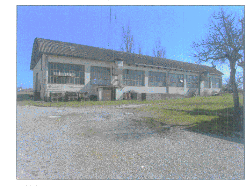
edificio D prospetto ovest
