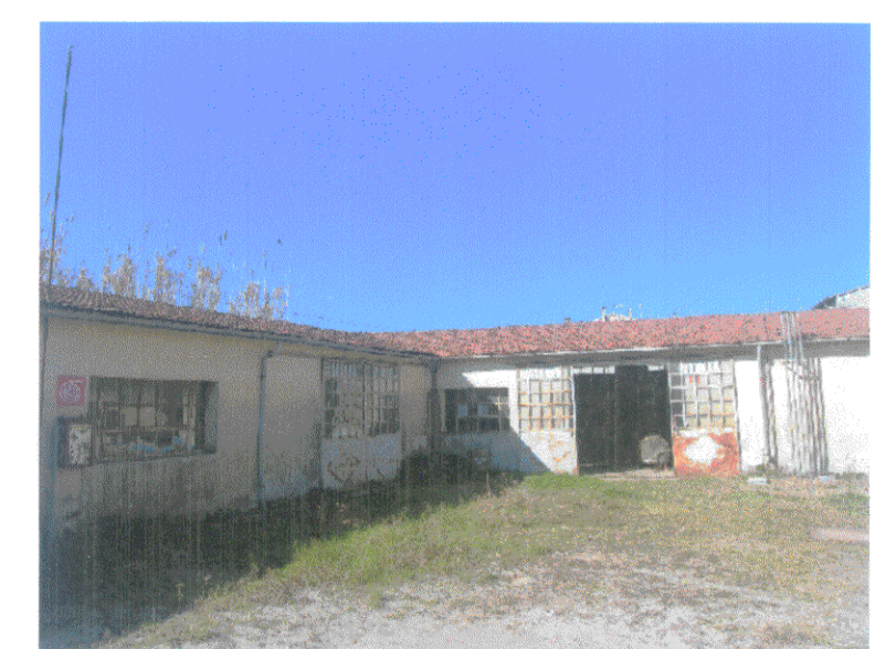
edificio C corte interna lati nord-est
