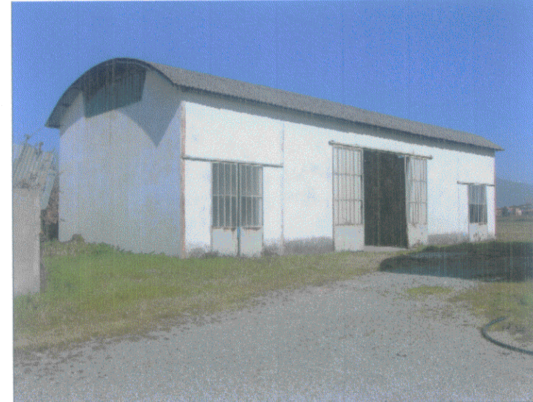
edificio B vista prospetto sud
