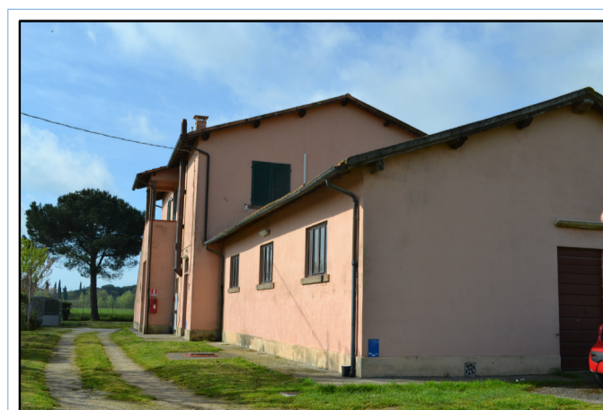
Manufatti Università di Pisa ubicati nell'area di intervento
