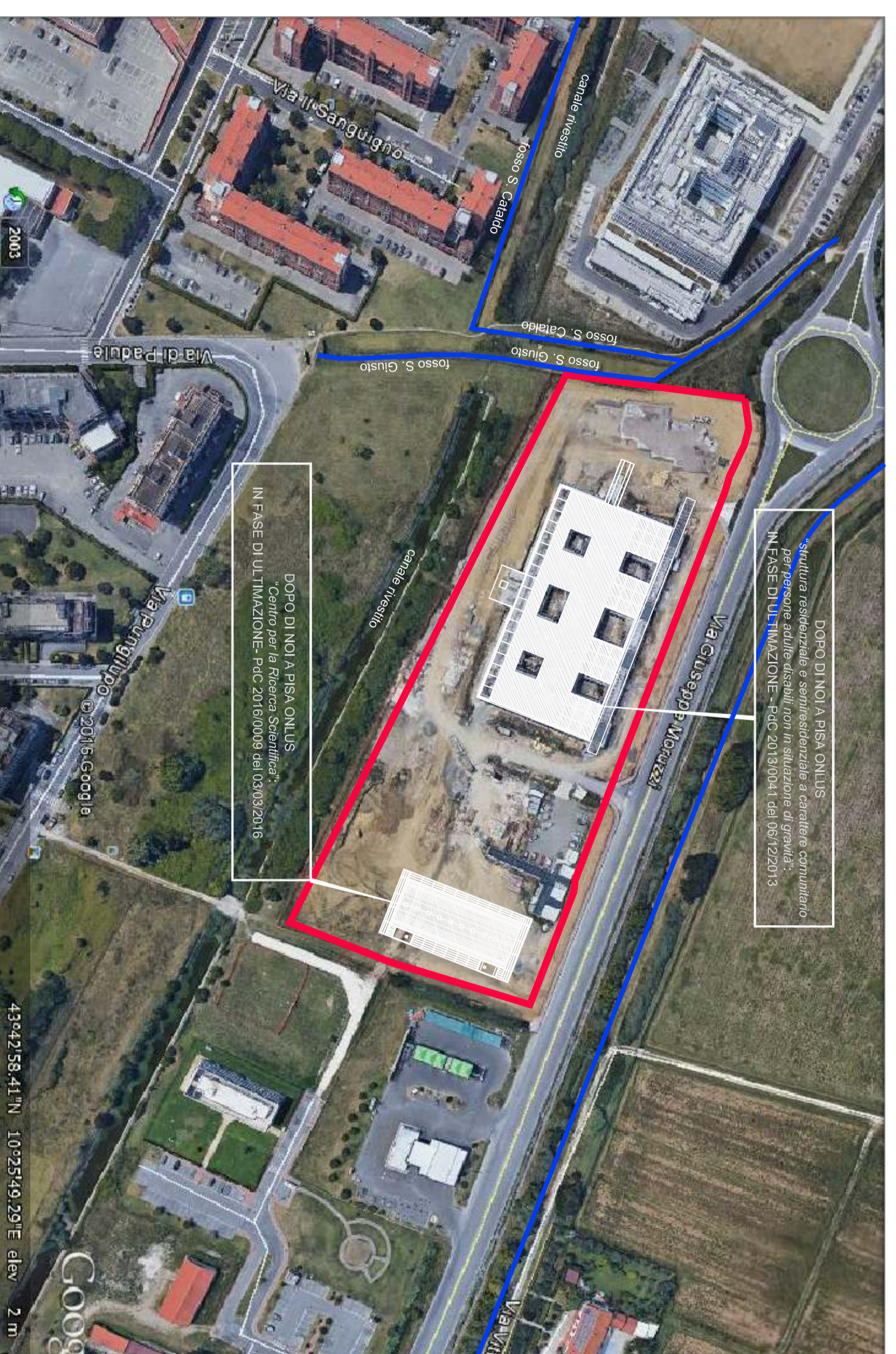
VISTA AEREA DI DETTAGLIO
