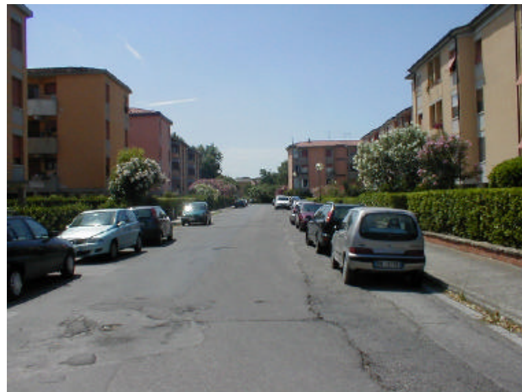
Foto 37- Via da Verazzano verso Via della Foce
