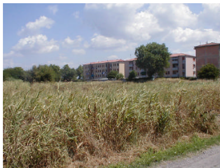
Foto 32 - Recettori Via da Verazzano lato ovest
