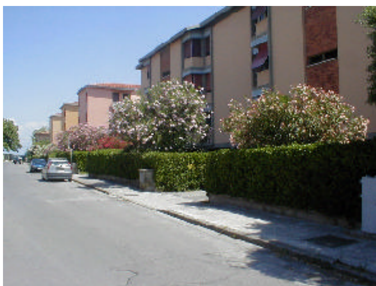
Foto 35 - Recettori Via da Verazzano lato finanza
