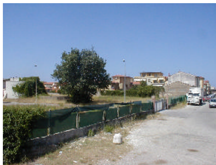
Foto 23 - Ingresso edificio acquedotto
