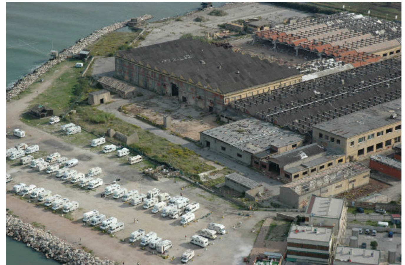
Foto 8– Vista aerea lato sud-ovest
