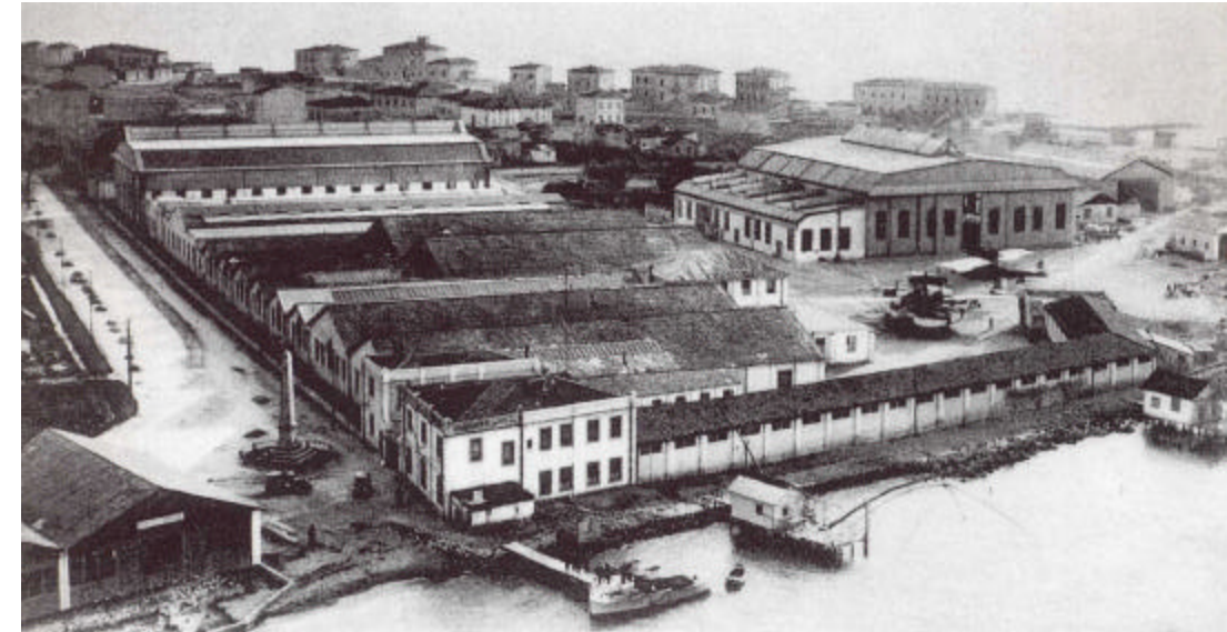
Fotografia d'epoca dello stabilimento industriale Motofides
