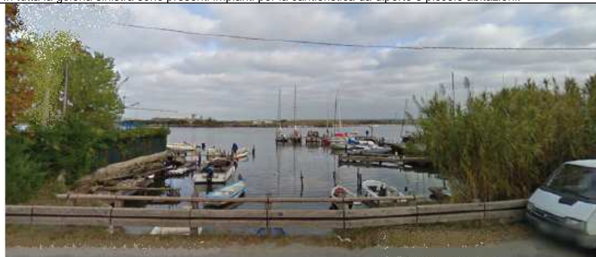
Emissario dell'idrovora sul Canale Lamone
