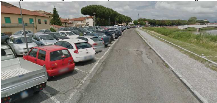
L'argine sinistro, costituito dal Lungarno Guadalongo.
