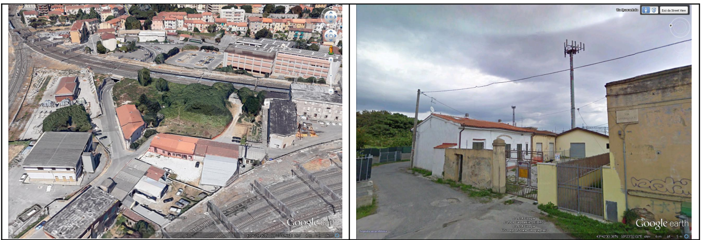
Foto aerea e prospettiva di via Quarantola n° 36,.
