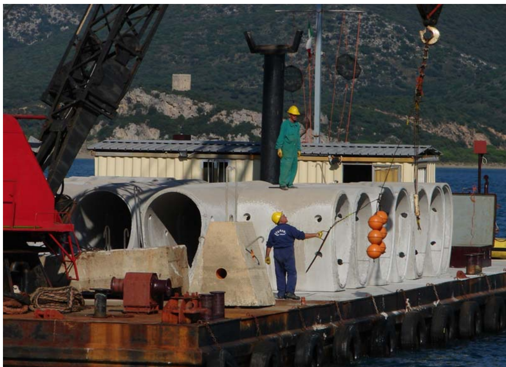
Barriere di ripopolamento stivate sul pontone per la messa in opera (foto Anselmi 2006)
