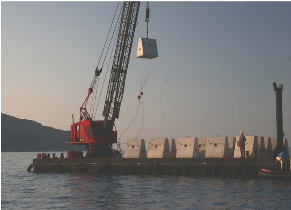
Blocchi dissuasori stivati sul pontone per la messa in opera (foto Anselmi 2006)
