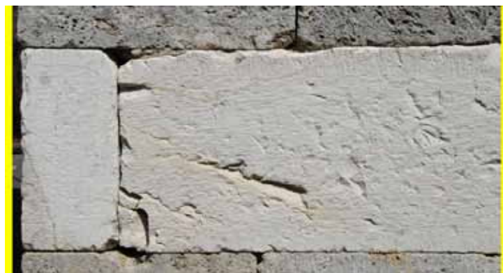
Figura 4: Postierla all'interno dell'area dell'ospedale. Particolare della lavorazione dei conci di calcare bianco dei montanti esterni del portale. I segni di lavorazione risultano molto evidenti.
