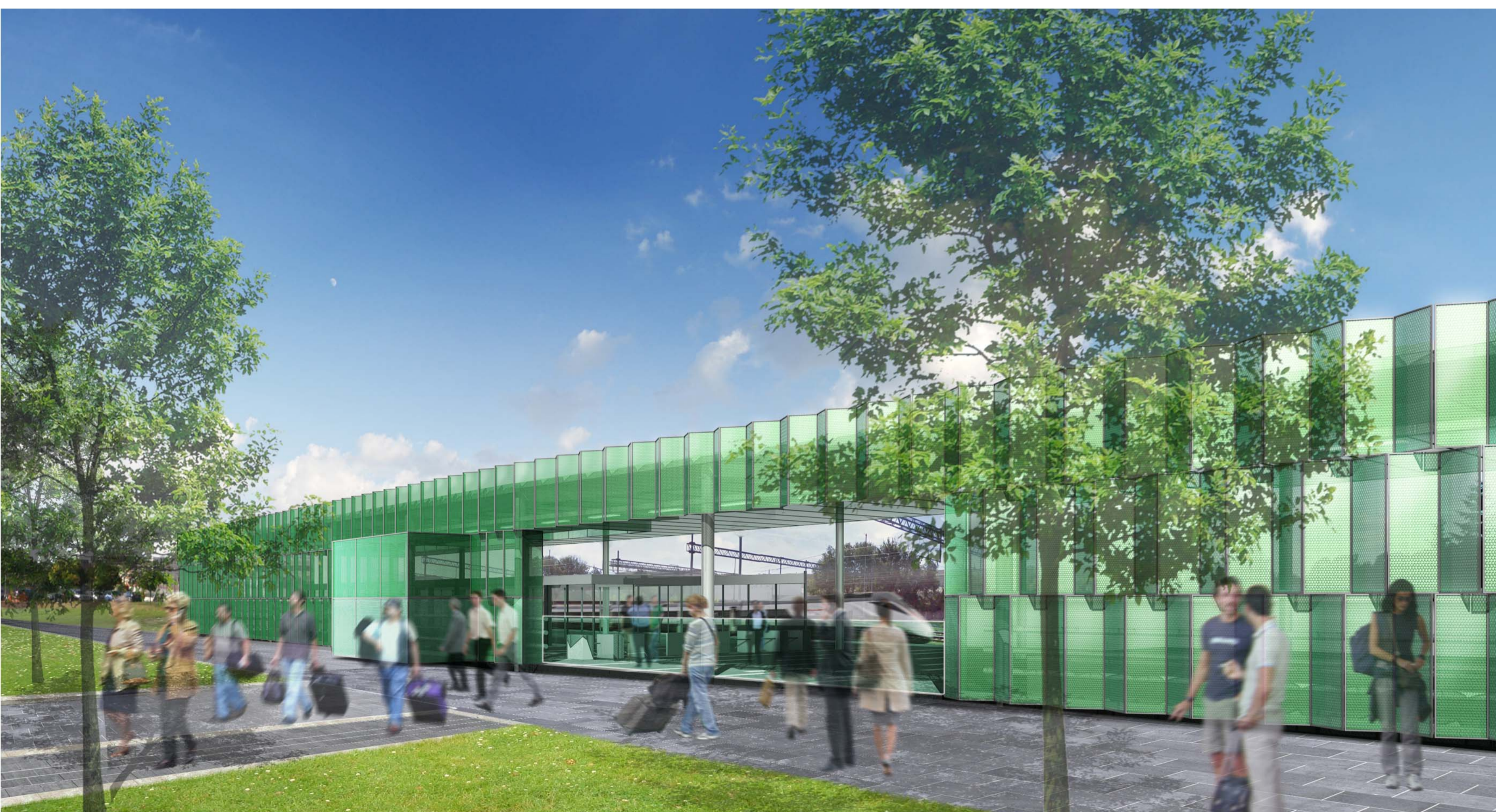
2_VISTA PROSPETTICA_IL FRONTE SUD
