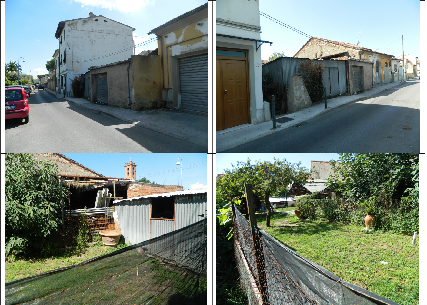
Foto prospetto su via Piastroni e annessi retrostanti.
