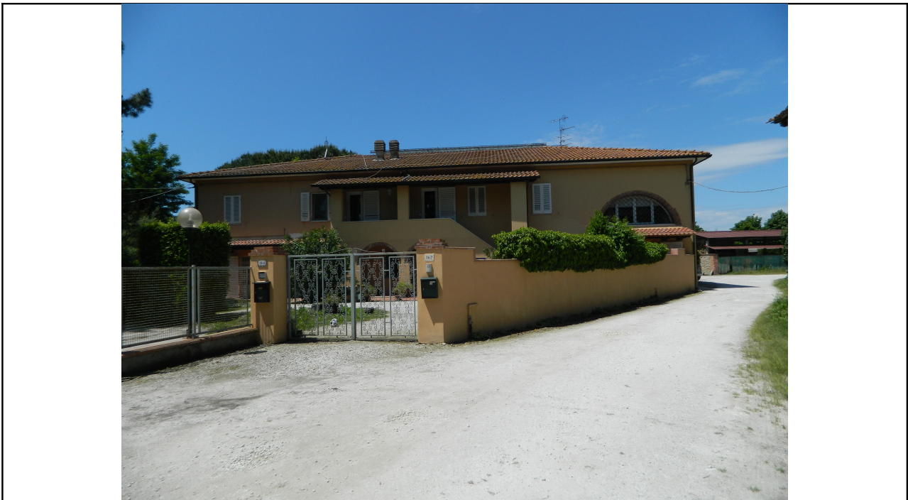
Foto prospetto principale Sud-Est
