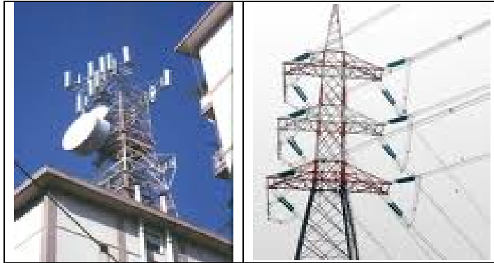
Foto stazione radio - elettrodotto
