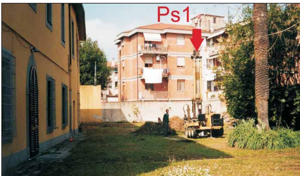
1 - ESECUZIONE PROVA Ps1
