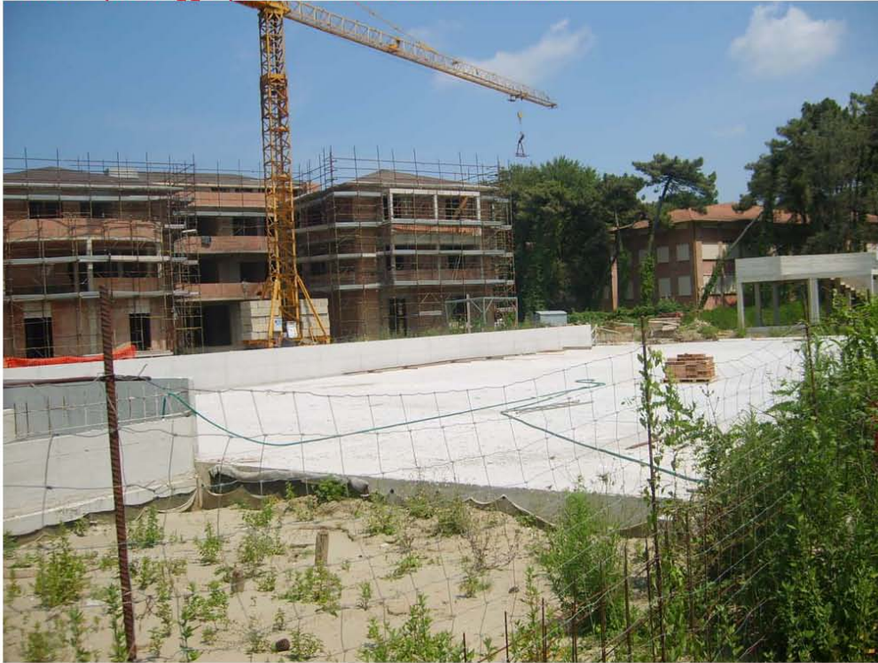
Foto 07 – parcheggio pubblico in corso di realizzazione
