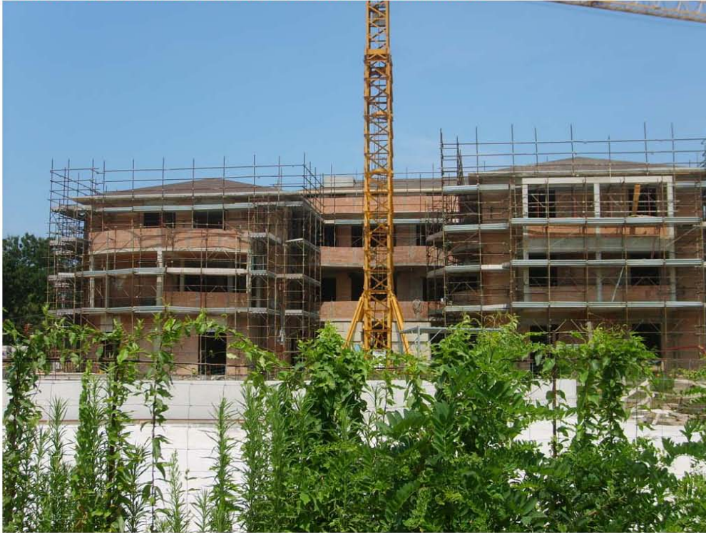
Foto 09 – ex-colonia S.Stefano in corso di ristrutturazione
