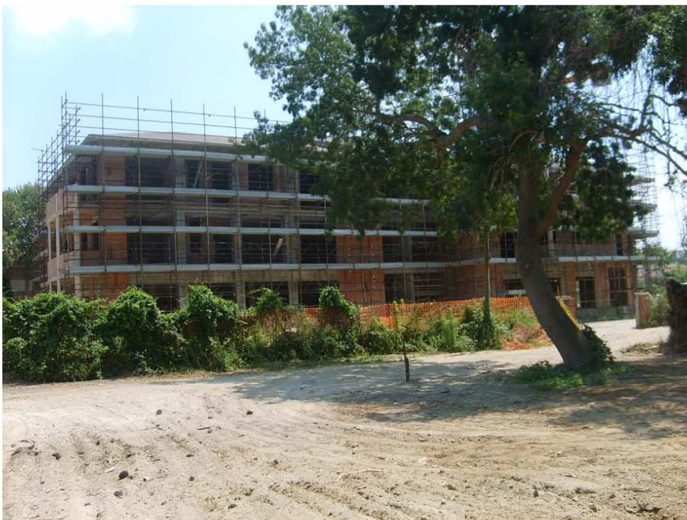
Foto 12 – ex-colonia S.Stefano in corso di ristrutturazione
