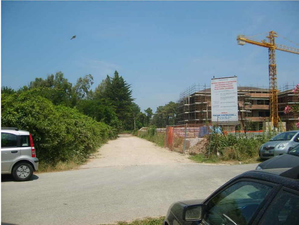
Foto 01 – accesso alla ex-Colonia S.Stefano
