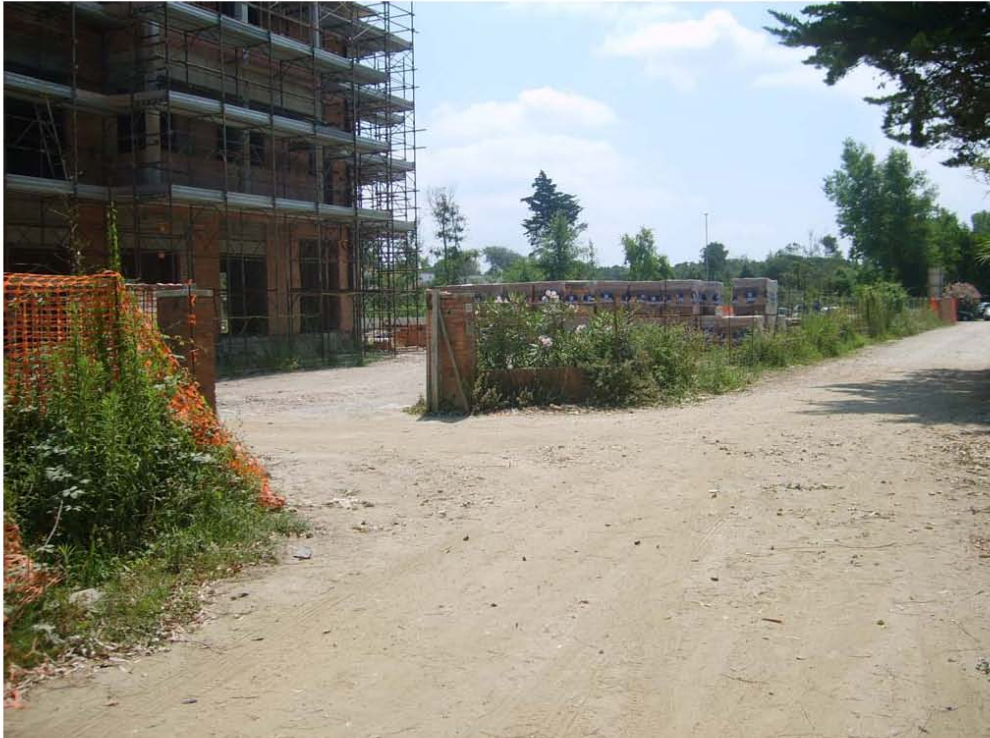
Foto 06 – accesso alla ex-Colonia S.Stefano
