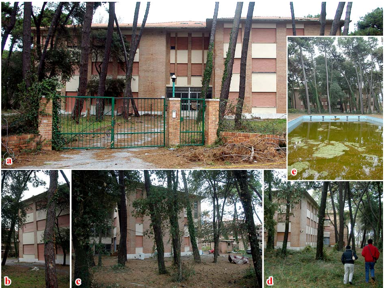
Figura 8.11 Ex colonia “Goffredo Nannini”. Nei riquadri: a) ingresso; b), c), d) area a verde, intorno all’edificio, con prevalenza di pino marittimo ( Pinus pinaster ); c) piscina nella parte nord della proprietà.
