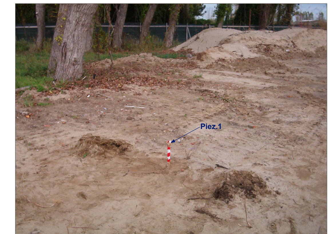
Foto n°8 : Testa della canna piezometrica (Piez.1) installata nel perforo della CPT1, all'interno della quale è stato prelevato un campione di acqua di falda per la misura speditiva in sito della conducibilità elettrica.
