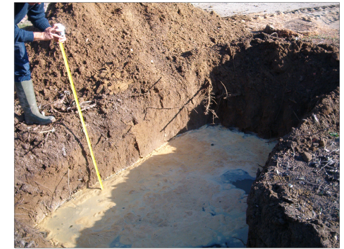
Foto n°3 : Particolare dello scavo (S2) per verifica livello di falda locale e campionamento d'acqua per misura speditiva in sito della conducibilità elettrica.
