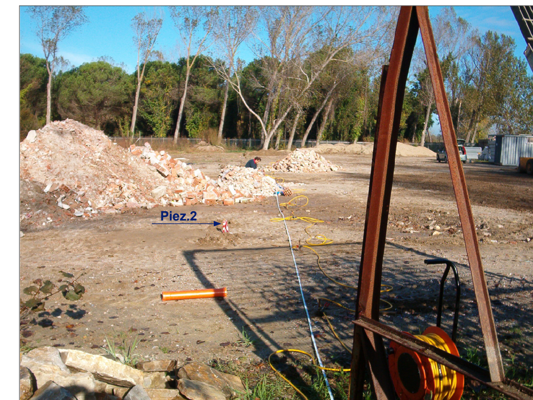
Foto n°7 : Panoramica dello stendimento (St.n°1) per l'esecuzione di tomografia elettrica lungo la direzione SSO-NNE, vista da SSO. A sinistra del cavo elettrico (in giallo) si nota la testa della canna piezometrica (Piez.2) installata nel perforo della CPT3 e foderata di nastro bianco-rosso. Lo stendimento, lungo 96,00 m, si sviluppa per quasi tutta la lunghezza del sub-comparto.
