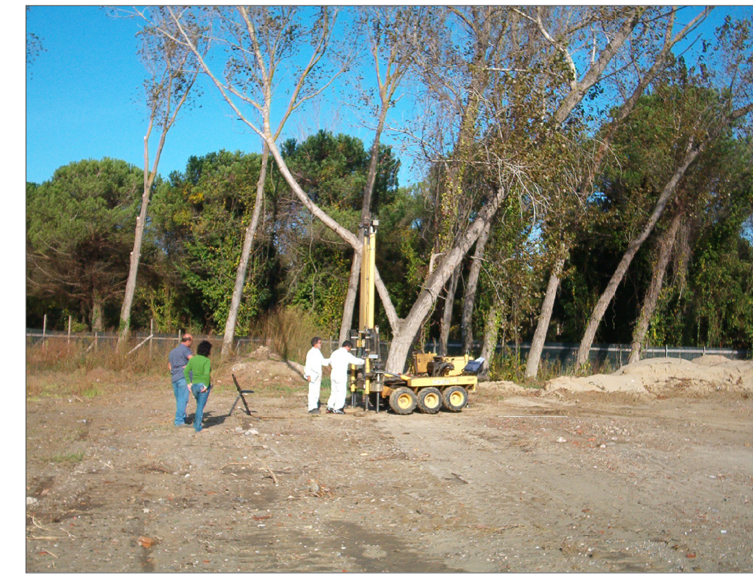
Foto n°2 : Esecuzione della prova penetrometrica statica CPT1, vista da SSE.
