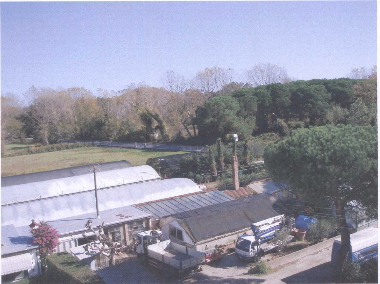
Foto 13 - Vivaio - Immagine dell'area interna del vivaio in cui si accostano diversi tipi di costruzione.
