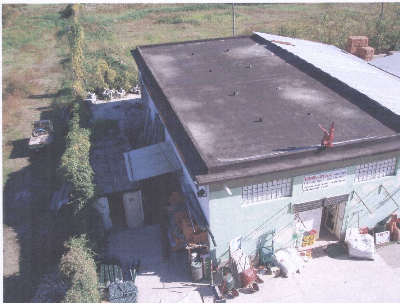
Foto 18 - Magazzino edile - Alla fine di via delle Giunchiglie, sul lato est, è collocato un magazzino edile. La costruzione è priva di valenze architettoniche e ricca di elementi provvisori, generati da esigenze logistiche dell'attività.
