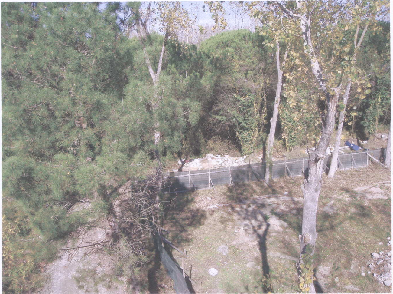
Foto 30 - Margine nord di via dei Ligustri - In questa immagine è visibile lo stato di degrado della zona: materiali di risulta sono abbandonati ovunque.
