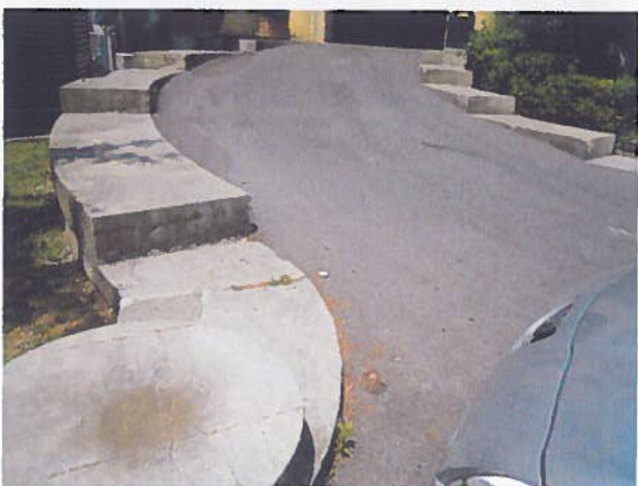
Particolare rampa Lato Est
