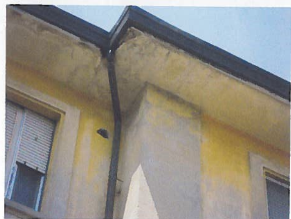
Particolare gronda lato Est
