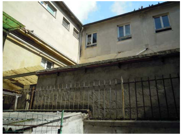
Prospetto interno cortile Nord-Est
