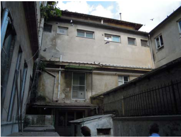
Prospetto interno cortile Nord-Est
