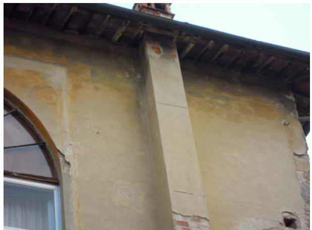
Particolare prospetto interno cortile Sud-Est
