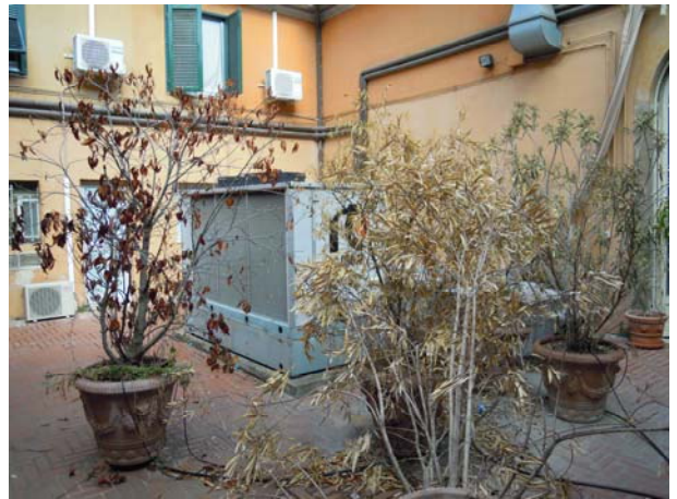
Prospetto interno cortile Sud-Est
