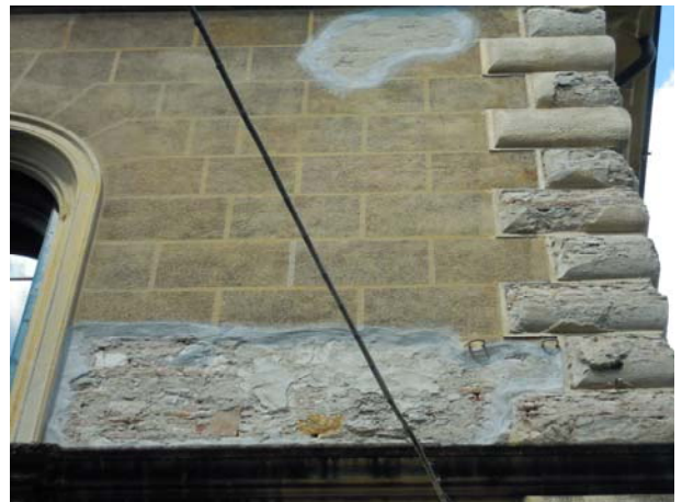
Particolare Prospetto Est
