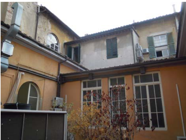
Prospetto interno cortile Sud-Est
