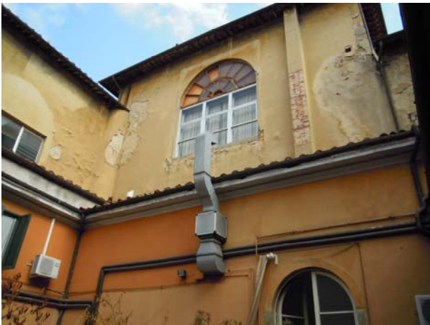
Prospetto interno cortile Sud-Est
