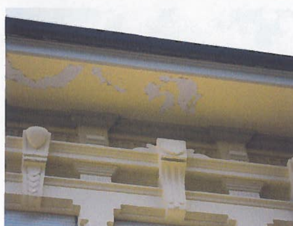
Particolare gronda Lato Sud
