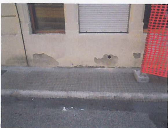
Particolare marciiede lato Ovest
