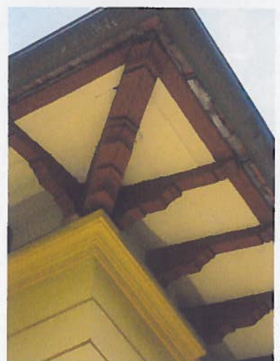
Particolare gronda lato Sud
