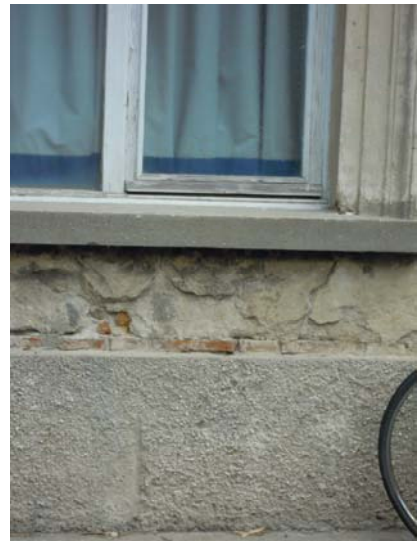
Particolare prospetto Sud
