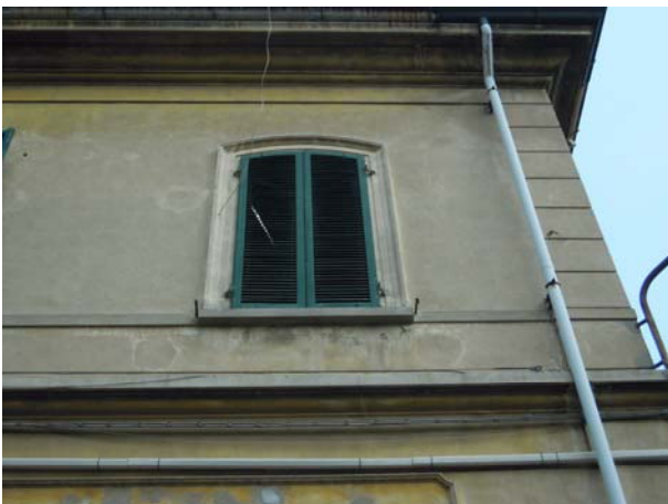
Particolare Prospetto Sud
