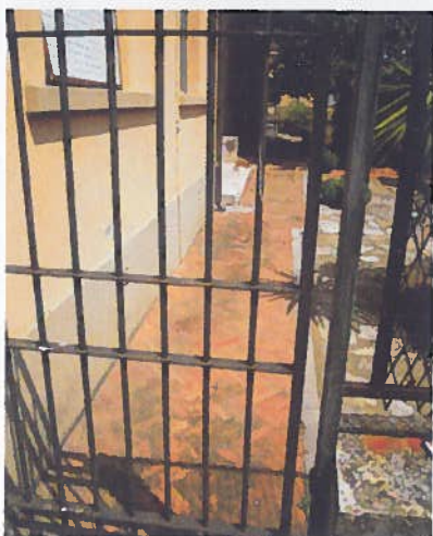
Particolare marciapiede lato Est
