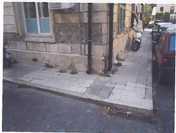
Particolare Prospetto e marciapiedi lato Ovest
