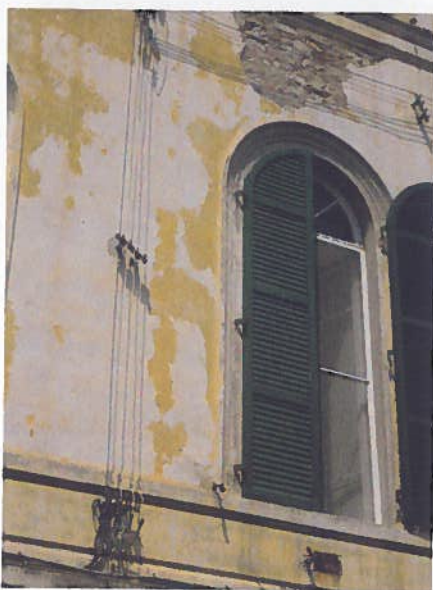
Particolare prospetto Ovest
