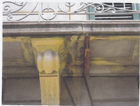
Particolare balcone lato Sud
