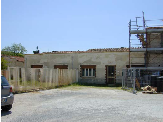
Foto del prospetto Edificio d'interesse
